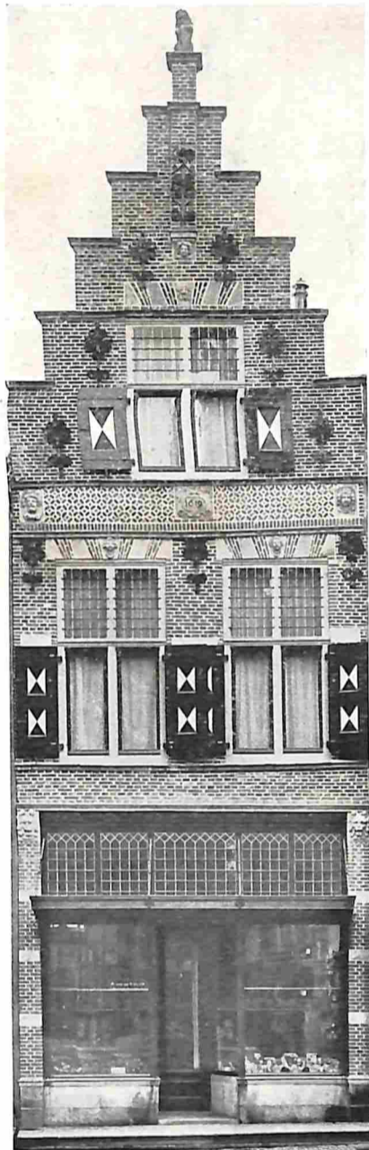
GEVELTJE TE AMERSFOORT, LANGESTRAAT 11, onlangs gerestaureerd onder toezicht van den architect W. van Schaik.
