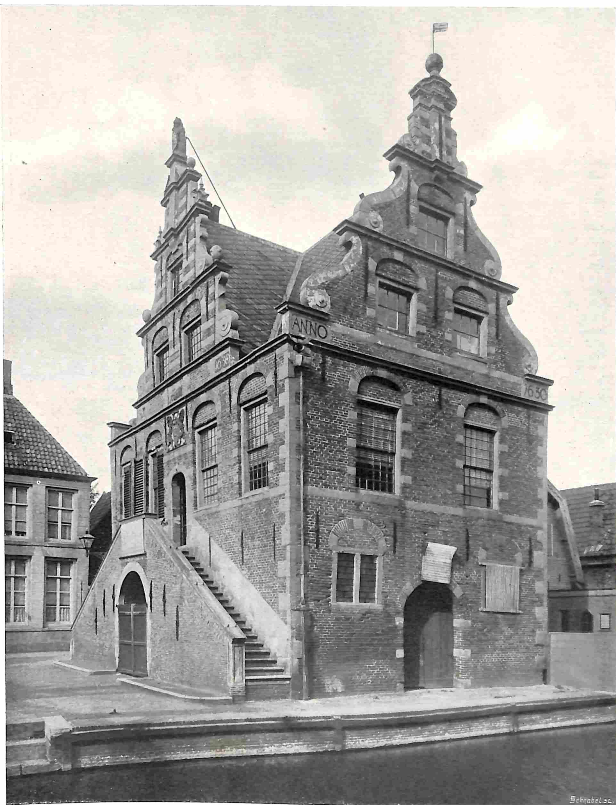
HET RAADHUIS VAN DE RIJK VOÓR DE RESTAURATIE, GEZIEN VAN 'T ZUIDWESTEN.
