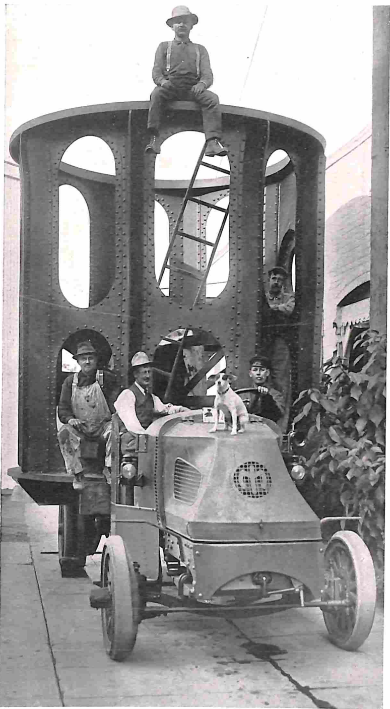
EEN HISTORISCHE DAG VOOR DE STERRENKUNDE. HET ZWARE ONDERSTE STUK VAN DEN 100 INCH SPIEGEL- TELESKOOP GEREED VOOR HET TRANSPORT NAAR DEN BERG.
