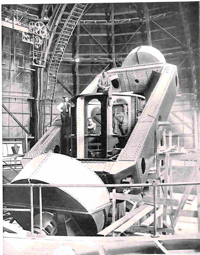
EEN HISTORISCHE DAG VOOR DE STERRENKUNDE. DE 100 INCH SPIEGELTELESKOOP IN AANBOUW; HET ONDERSTE KIJKERSTUK WORDT IN DE POOL-AS GEHANGEN.
