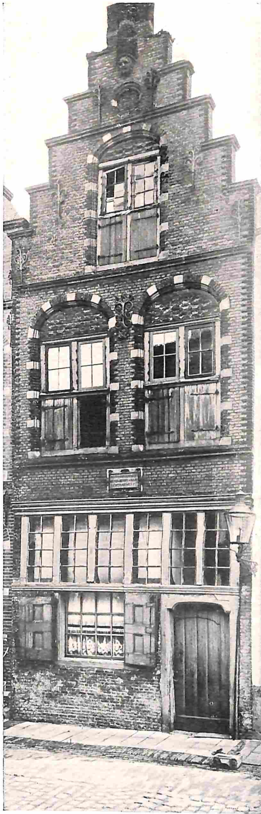
GEVEL VAN HET WOONHUIS „DE ARK”. WIJDSTRAAT 18, OUDEWATER, GEBOUWD IN 1615, VÓÓR HET HERSTEL.
