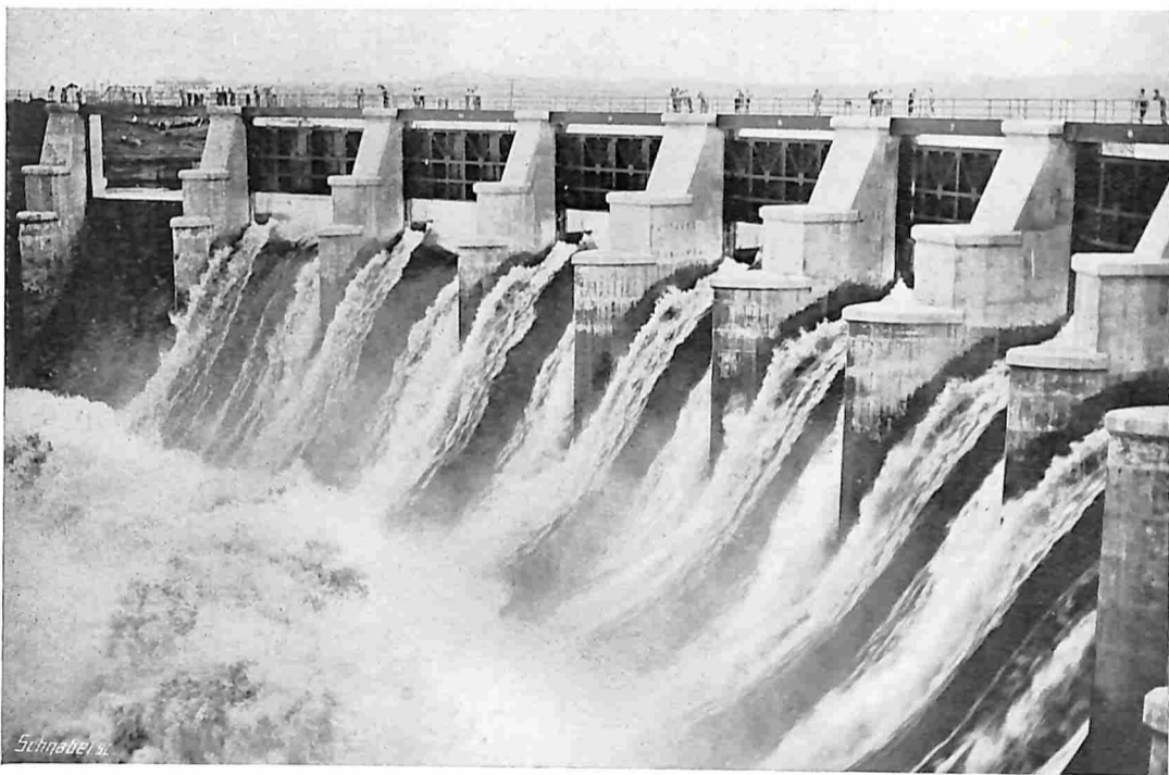
DE AFSLUITDIJK IN HET PANAMA-KANAAL BIJ GATOEN. DE OVERLAAT VOOR HET EERST IN WERKING. ZEVEN DER DERTIEN DEUREN ZIJN GEOPEND.
