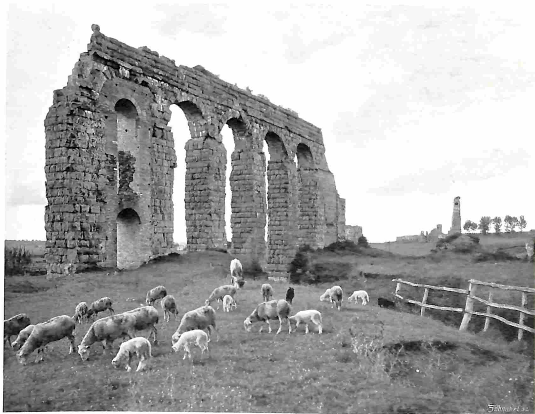
BROKSTUKKEN VAN EEN AQUADUCT BIJ DE VIA APPIA.
