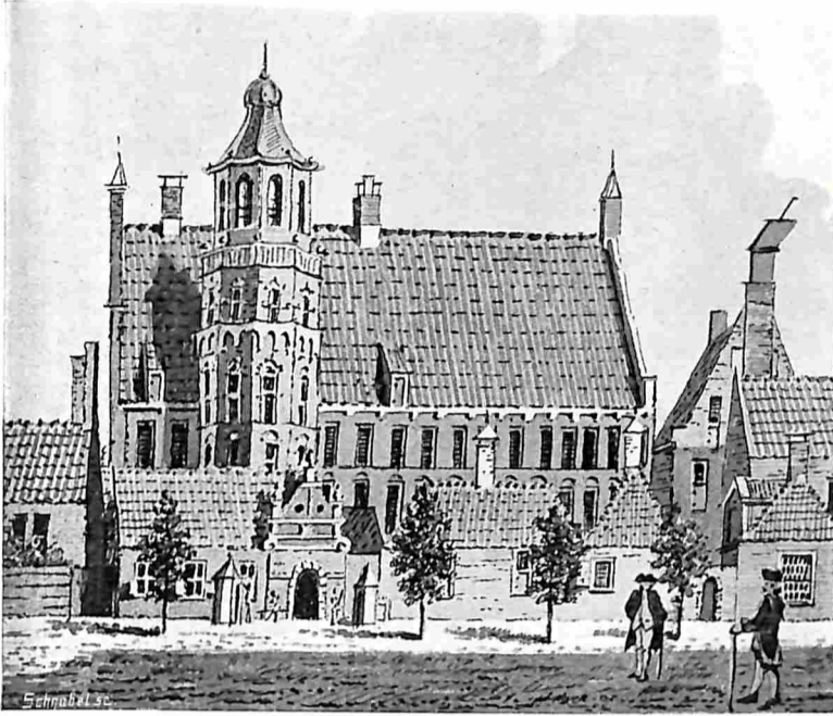
HET PROVINCIEHUIS TE GRONINGEN VOOR ZIJN VERBOUWING.
