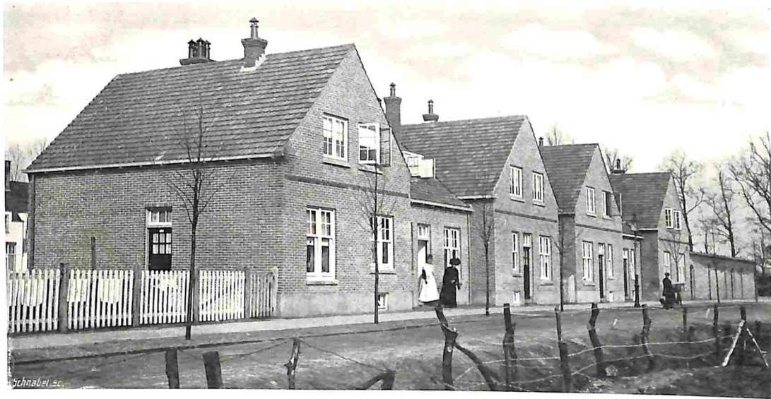
HUIZEN AAN DE BECKUMMERSTRAAT. TWEË BLOKKEN IEDER VAN DRIË EENVOUDIGE RUIME WONINGEN.
