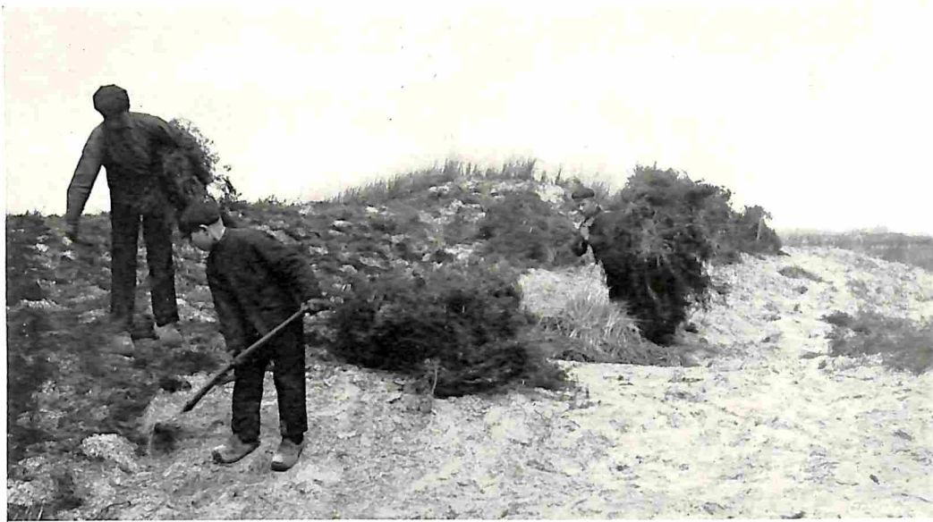
HET VASTLEGGEN VAN EEN ZANDVERSTUIVING.
