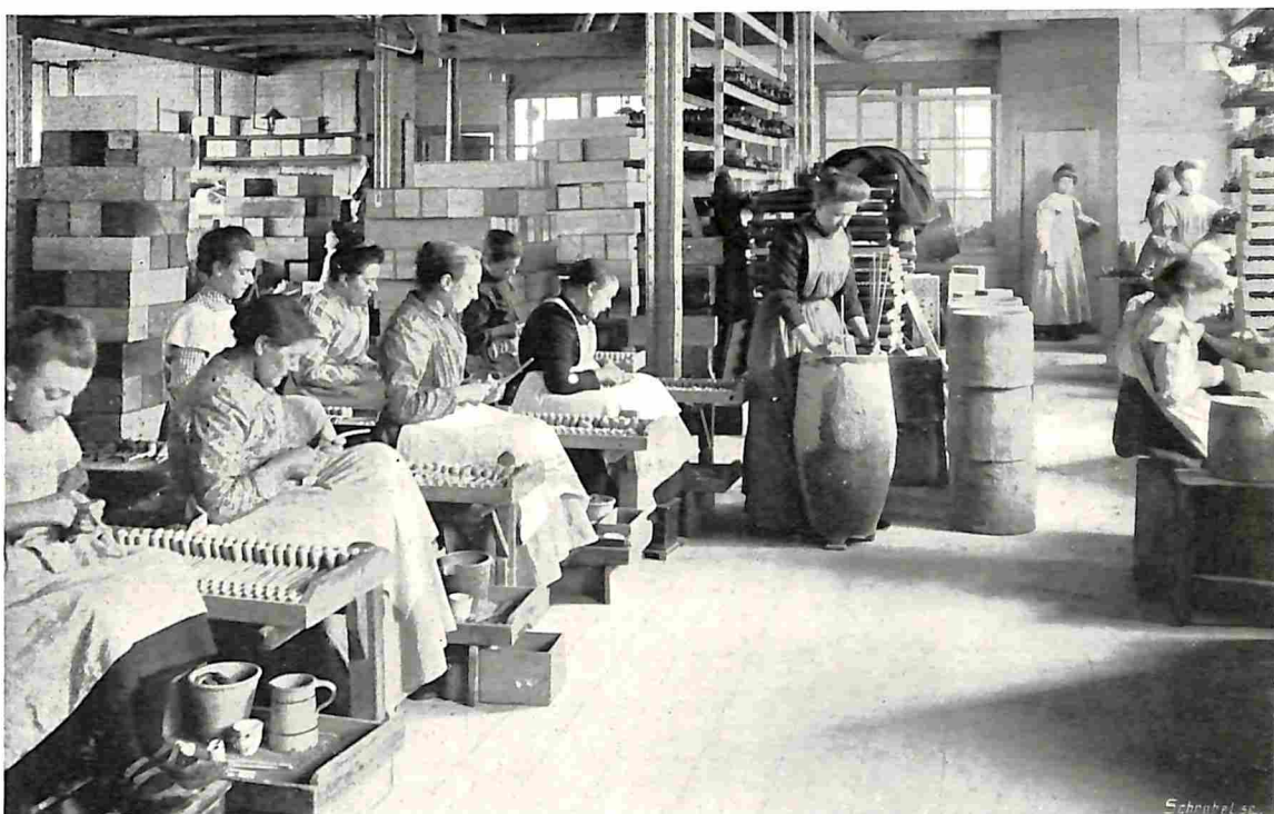
HET GLANZEN EN PLAATSEN DER PIJPEN IN VUURVASTE POTTEN.
