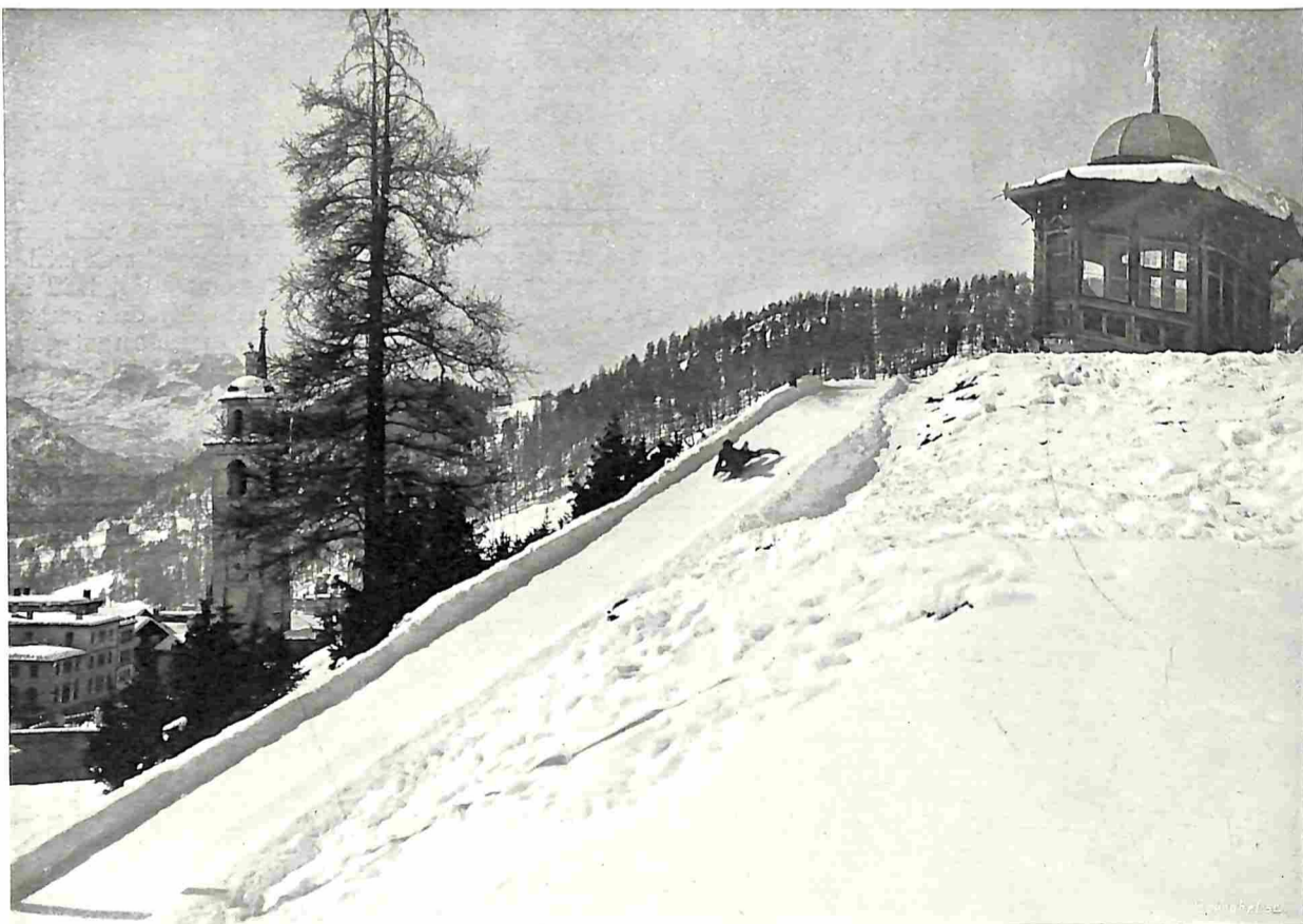
ST. MORITZ. HET BEGIN VAN DE CRESTA-BAAN.
