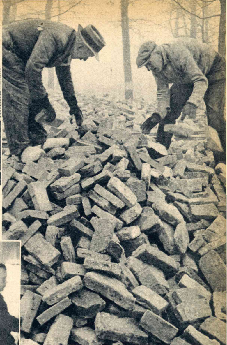
Het puin van de ruïnes te Wageningen is vrijwel geheel opgeruimd. Binnenkort zal men nu beginnen met den wederopbouw van deze plaats, waartoe alle bruikbare steenen worden afgebikt.
