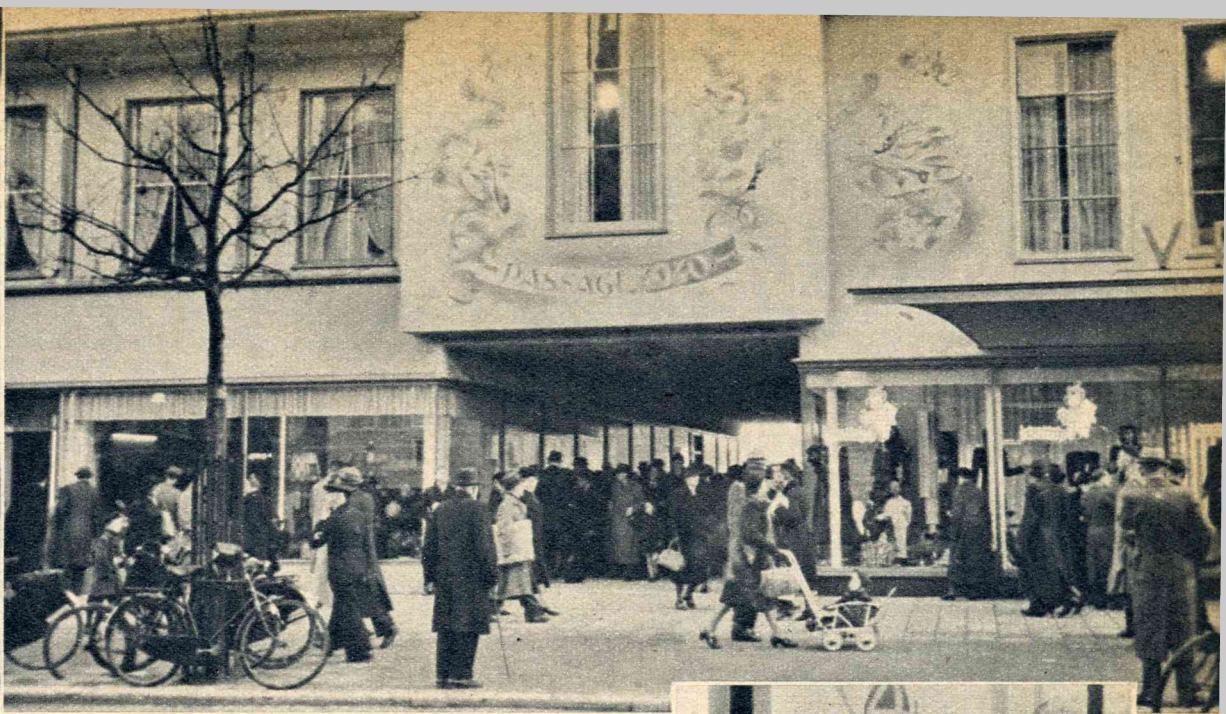
Nu de bekende oude Passage, aan den Coolingsingel, is verdwenen, is de nieuwe „Passage 1940”, langs den Nieuwen Binnenweg, een bescheiden, maar sierlijk en stijlvol „plaatsvervangster”. De fresco's zijn van de hand van Pieter den Besten.
