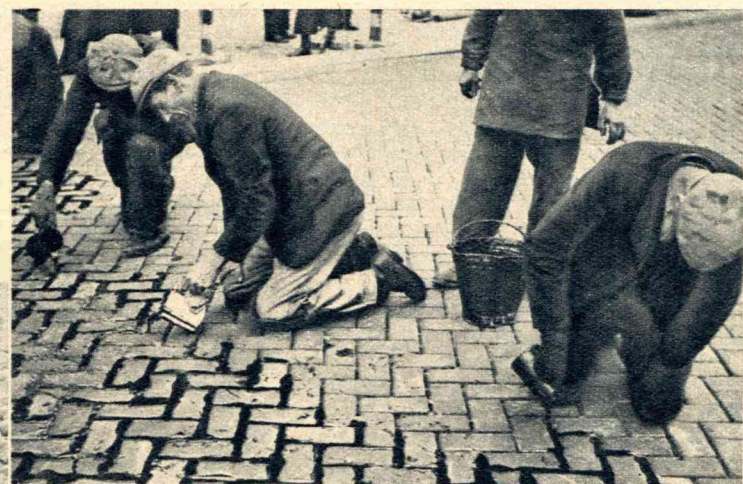
In de 1e van Swindenstraat te Amsterdam wordt een proef genomen met een nieuw soort bestrating, die uit twee deelen bestaat. De onderlaag wordt gemaakt van klinkers, waarop men zand strooit, terwijl het wegdek zelf bestaat uit steenen, waartusschen teer wordt gegoten. Men verkrijgt aldus in de voegen richels van teer, die de kans op slippen sterk verkleinen.
