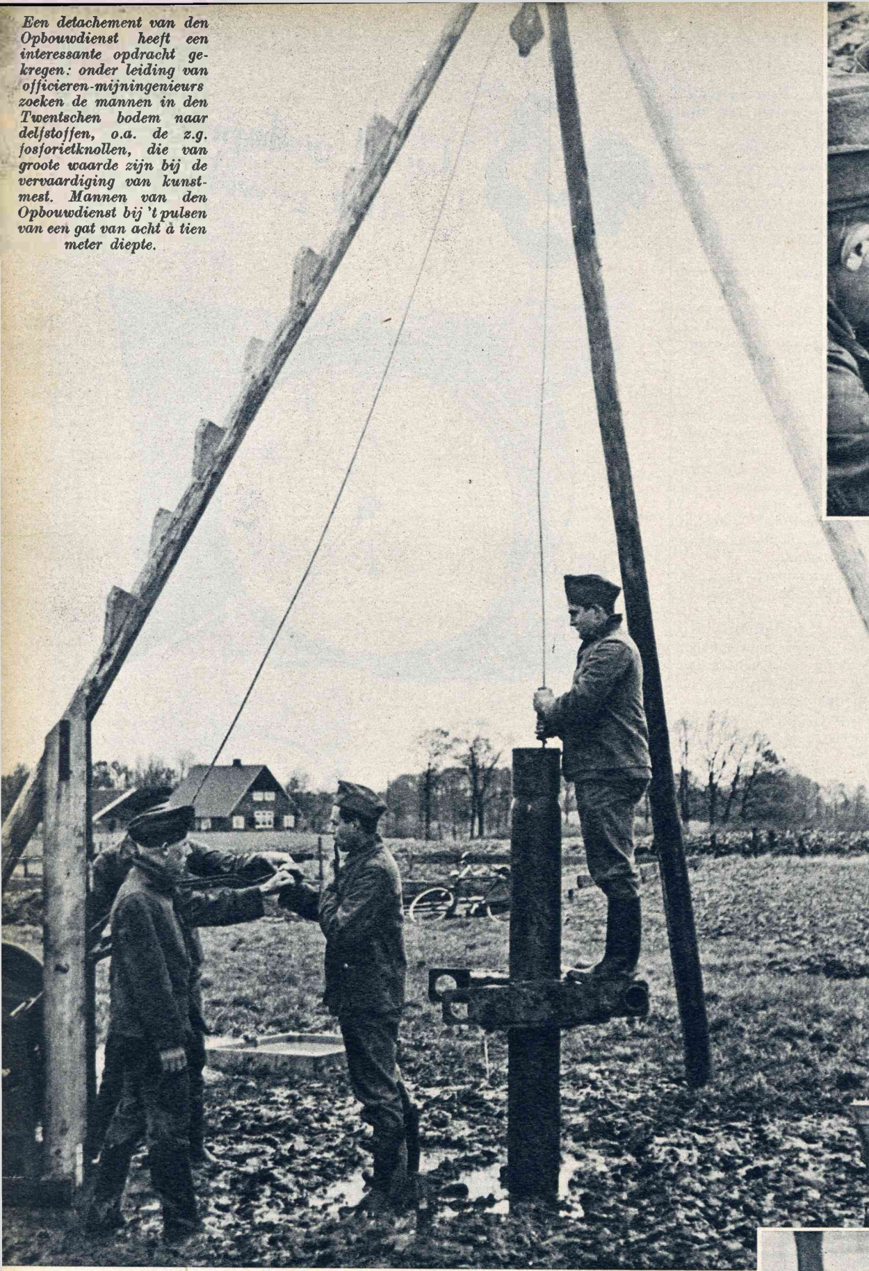
De spiraalboor, die wordt gebruikt voor 't boren van putten.
