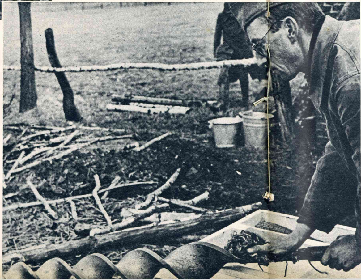
De spiraalboor, die wordt gebruikt voor 't boren van putten.
