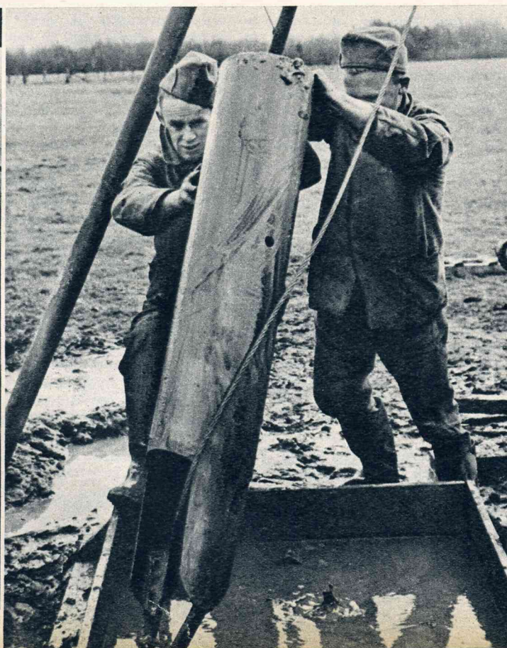
Na een boring wordt het water uit de puls gegoten, de opgehaalde grond blijft achter.
