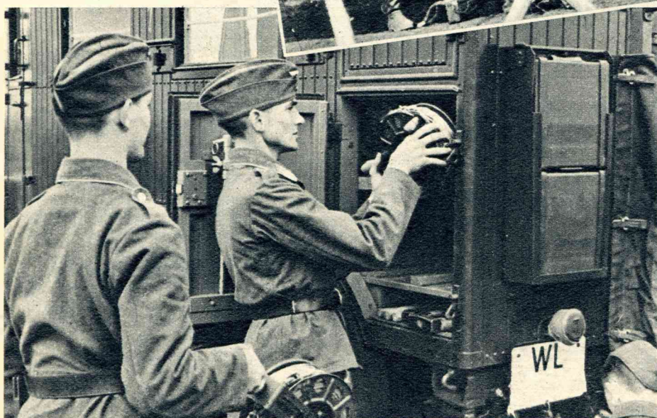
Een telefoonkabel wordt uit den antennewagen genomen.
