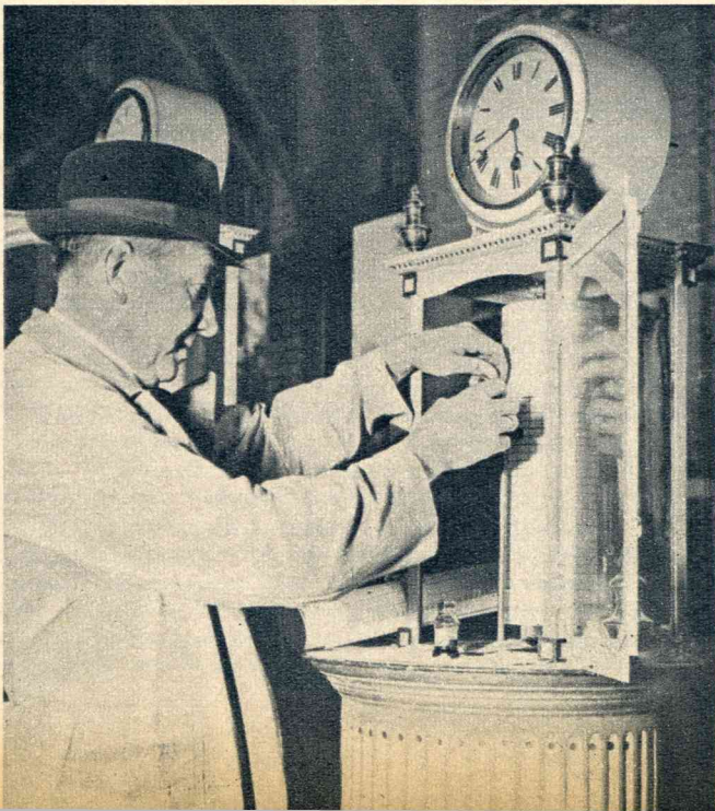
Een registreerende drukmeter, die den druk van het aan de stad afgeleverde gas opteekent.
