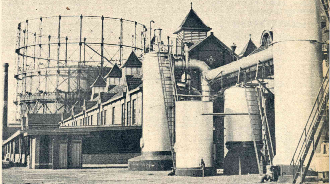
Een overzicht van de Zuidergasfabriek te Amsterdam. Op den voorgrond de enorme cylinder, waarin het gas door middel van watersproeijs van ammoniak gereinigd wordt. Midden achtergrond — de middensoort cylinder — hierin wordt het gas gereinigd van de laatste teerresten door middel van electrische afstooting.
