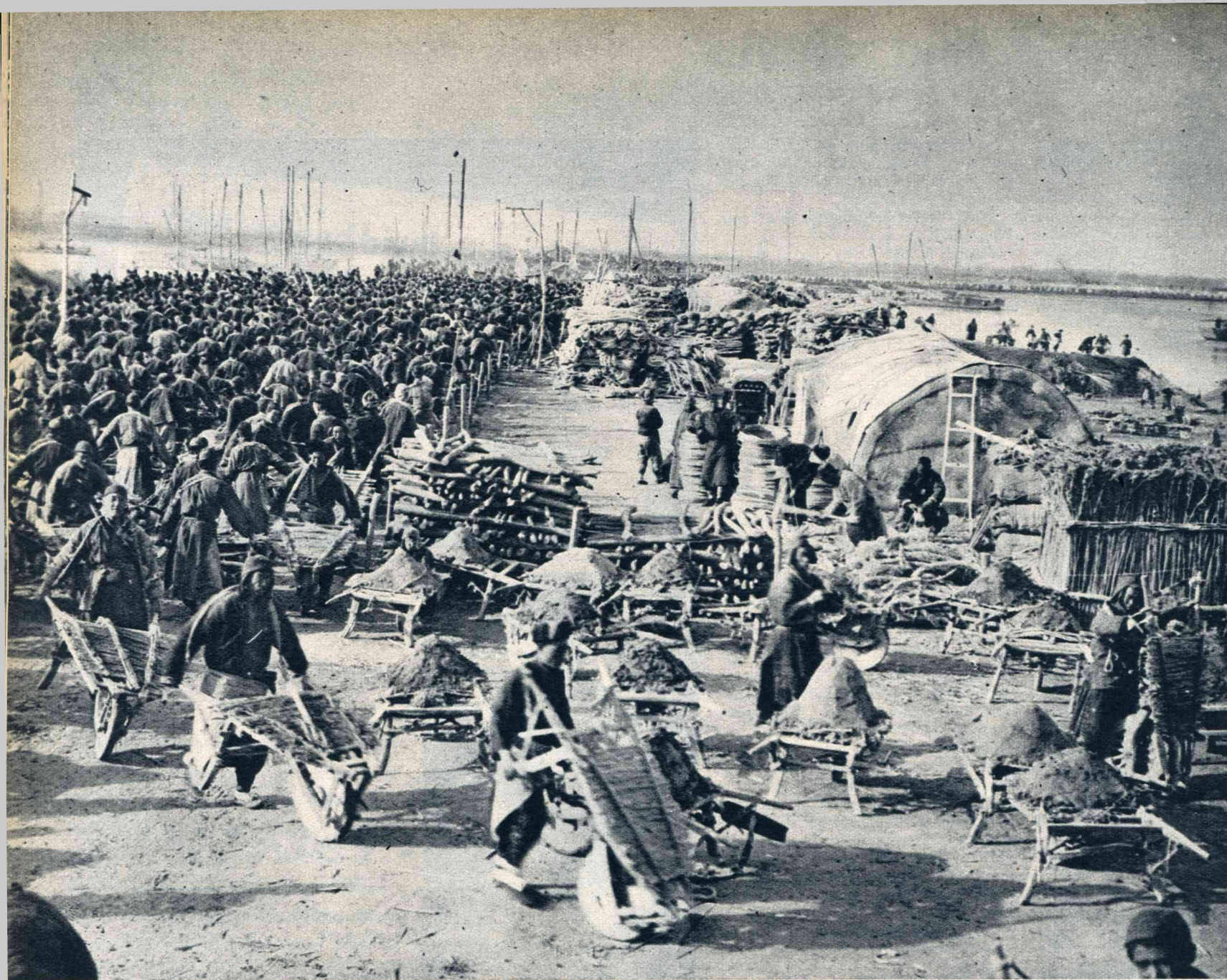
Tienduizenden arbeiders worden tegen laag loon aangenomen om het gat in den dijk te dichten. Zij nemen primitieve gereedschappen mee: miljoenen meters touw, wilgetwijgen, steenen enz. worden op primitieve kruiwagens vervoerd, juist als hun voorouders duizenden jaren lang deden.
