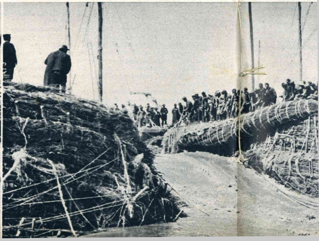
Nadat de zinkstukken met touwen vastgemaakt zijn laat men ze in de rivier neer, doch ze blijven aan het stu
