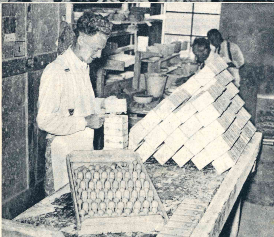
De omstandigheden brengen mee, dat hartstochtelijke rookers zich toe gaan leggen op het rooken van pijpen. Vandaar dat de pijpenindustrie plotseling is opgeleefd. Na het gieten van de pijpen worden ze uit de vormen gehaald. (Foto Polygoon)
