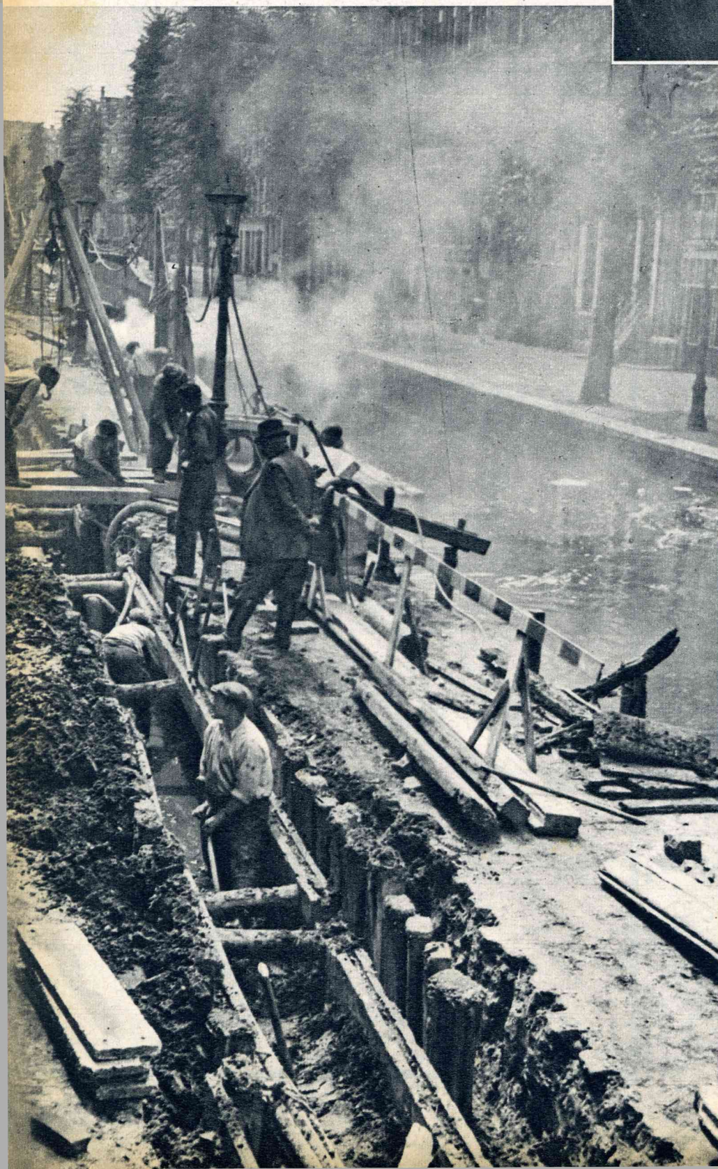
Een der kolossale nieuwe putzuigmachines stort zijn viezen last in een der schuiten van de Stadsreiniging, welke hygiënisch overdekt in de grachten liggen en het verzamelde slib naar de buiten de stad gelegen baggerbergplaatsen brengen.
