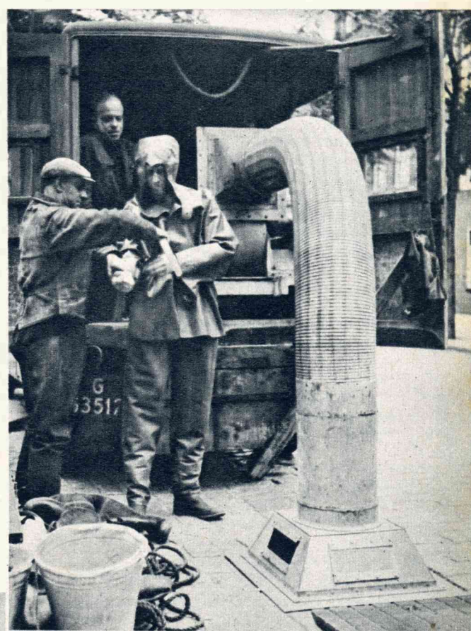
Het afdalen in het hoofdriool van Amsterdam is geen kinderspel! De riolen zijn nooit geheel droog en het vuile water kan hevige infecties veroorzaken. Bovendien moet door middel van een versersingsmachine versche lucht in het riool gepompt worden, omdat het rioolwater zware gifgassen ontwikkelt.
