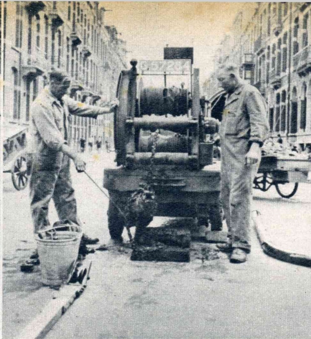
De vuile „kat” komt uit de rioolbuis naar boven, het opstoppende slib is door het schuren van de „kat” uit de buis in den put gekomen. De ketting wordt losgemaakt, en weg rijden de mannen voor een andere rioolbuis.
