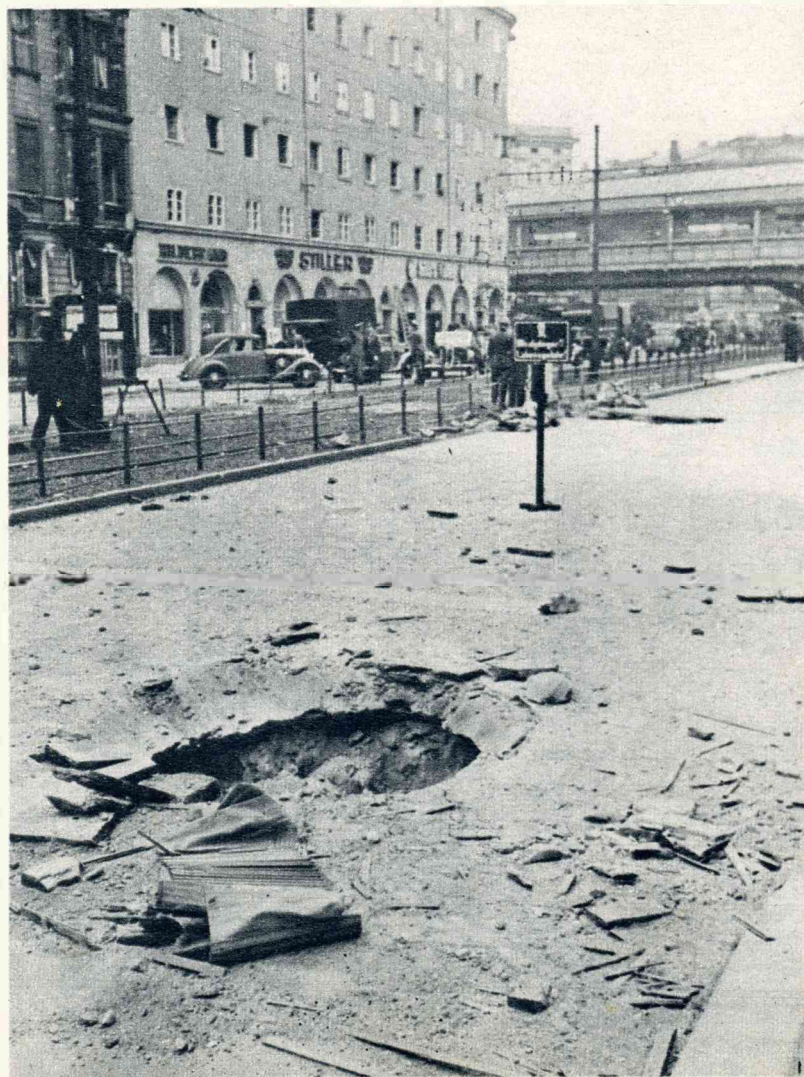
Het gat in een der straten, veroorzaakt door een blindganger.
