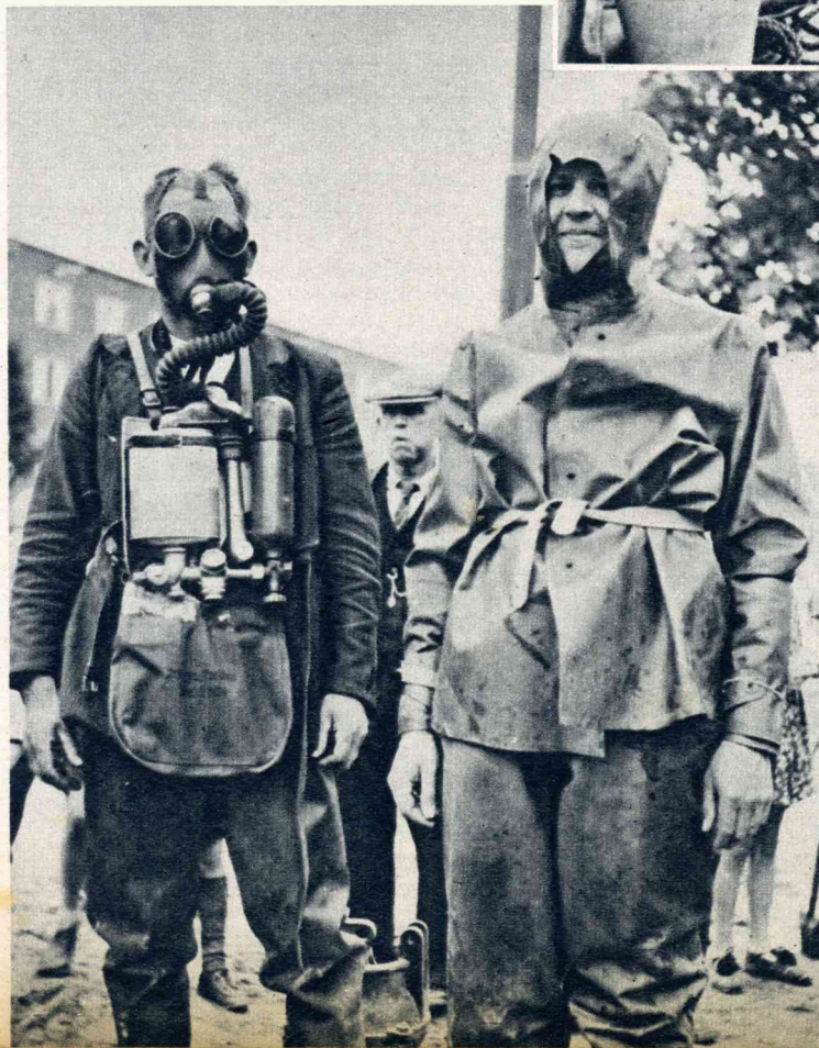
Het afdalen in het hoofdriool van Amsterdam is geen kinderspel! De riolen zijn nooit geheel droog en het vuile water kan hevige infecties veroorzaken. Bovendien moet door middel van een versersingsmachine versche lucht in het riool gepompt worden, omdat het rioolwater zware gifgassen ontwikkelt.
