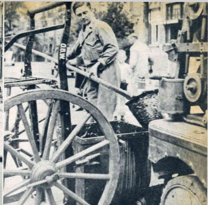
Als het slib uit de buizen in den put verzameld is, wordt het of met putzuigmachines er uitgezogen, ofwel met behulp van „handenwerk” met een schepzak uitgeschept in een karretje, waarvandaan het in de S.R.-schuiten gestort wordt.
