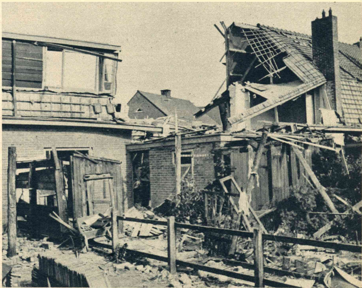
Gebroken ruiten, pannenlooze daken zelfs in de woningen, die niet getroffen werden.
