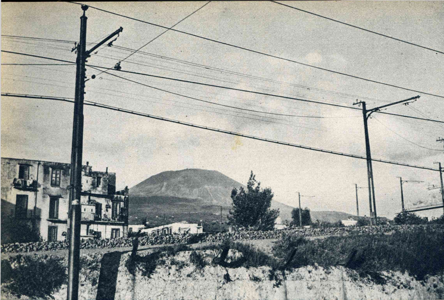
Het station Pugliano van den electrischen spoorweg, die tot aan het uitgangspunt voert van de kabelbaan, aan den voet van den eruptie-kegel van den Vesuvius.
