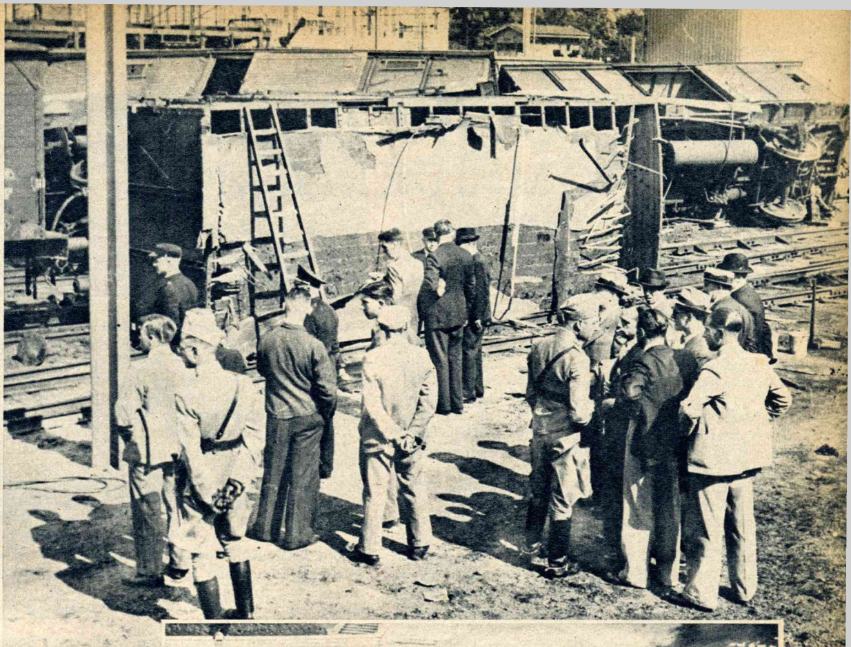
Dinsdagmiddag ontspoorde ten gevolge van een verkeerden wisselstand op het emplacement „Uit en in” te Utrecht een goederentrein. Een overzicht van de ravage.
