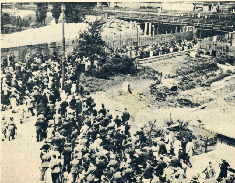
Als onderdeel van het groote tunnelplan te Rotterdam bouwen de Spoorwegen zes verkeerstunnels naast elkaar onder het emplacement bij de Henegouwerlaan. De bestaande tunnel kan thans het verkeer bijna niet meer verwerken. — Een foto van den menschenvloed, die den geheelen dag aanhoudt. Achter de schutting de nieuwe tunnel in aanbouw.
