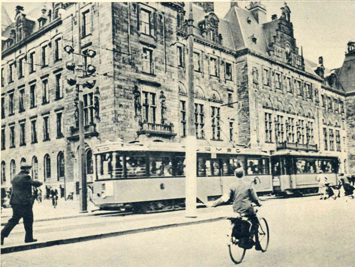
Het tramverkeer te Rotterdam wordt geleidelijk hersteld. — Na vele dagen reed de eerste tram weer langs de route Coolsingel. — Links het raadhuis.
