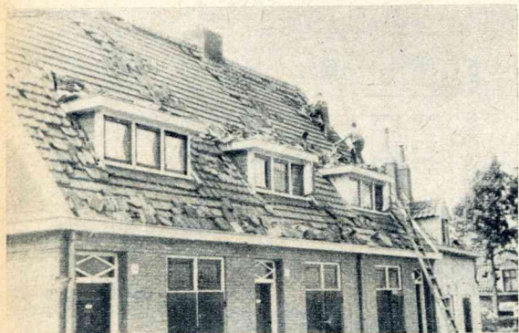
Herstelwerkzaamheden na een angstigen tijd. Een kijkje op de Hoven te Zutphen.
