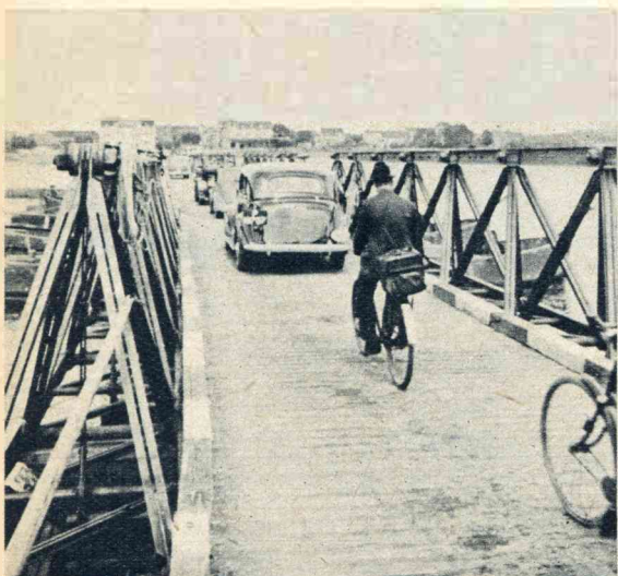
Daar de bruggen bij Nijmegen over de Waal zijn opgeblazen, sloegen de Duitsche pontonniers een noodbrug, waarover thans het verkeer wordt geleid.
