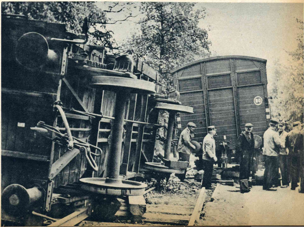
Het spoorwegmateriaal, dat tusschen Bennekom en Wageningen door ons leger ter versperring was neergeworpen, wordt door het spoorwegpersoneel weer opgeruimd.
