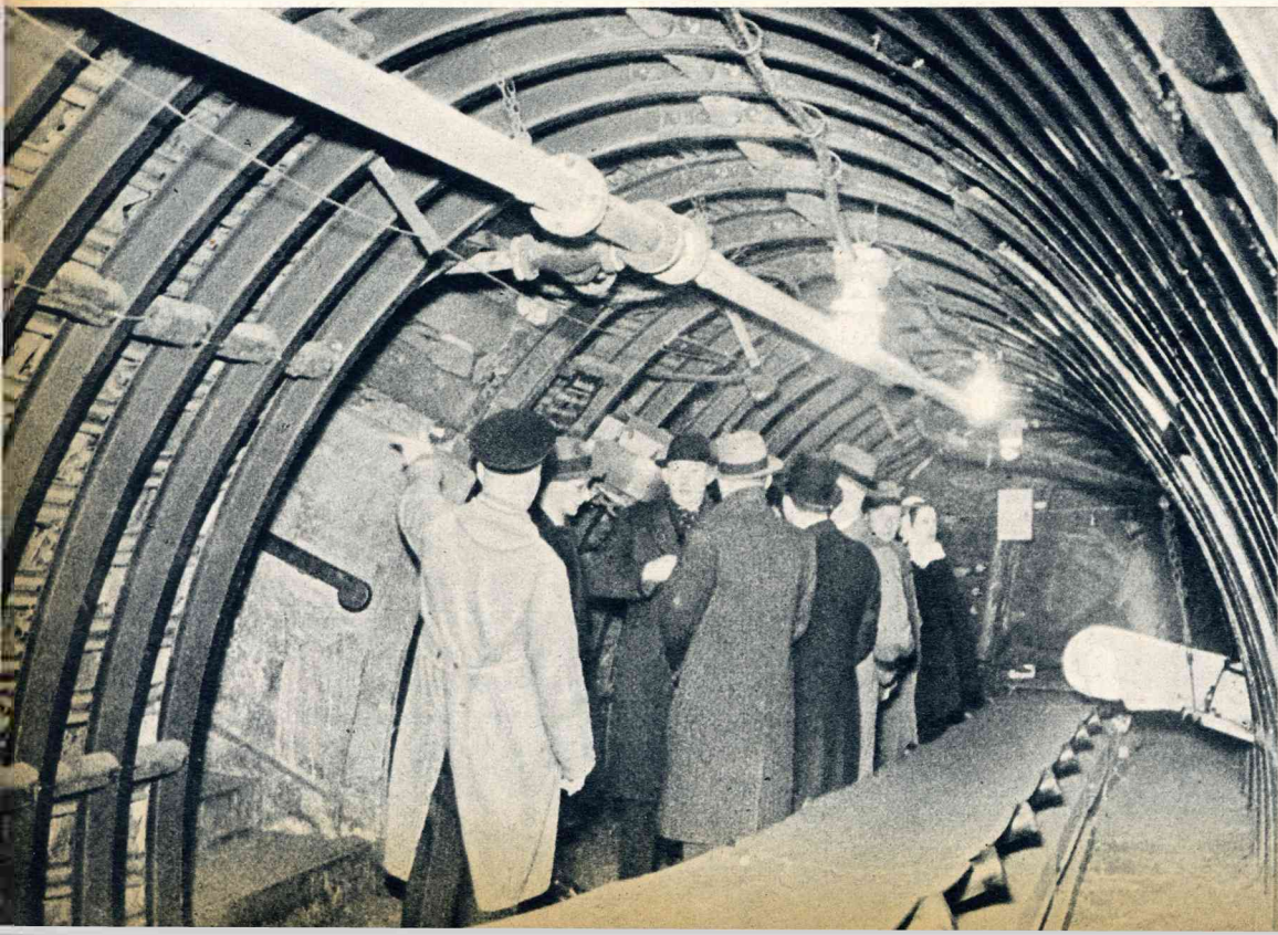
Een bezoek aan een kolenschacht. Op den voorgrond een gummi-transportband.
