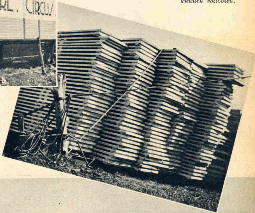
Hooge stapels planken liggen geheel gereed om den afbouw van het circus te kunnen voltooien.
