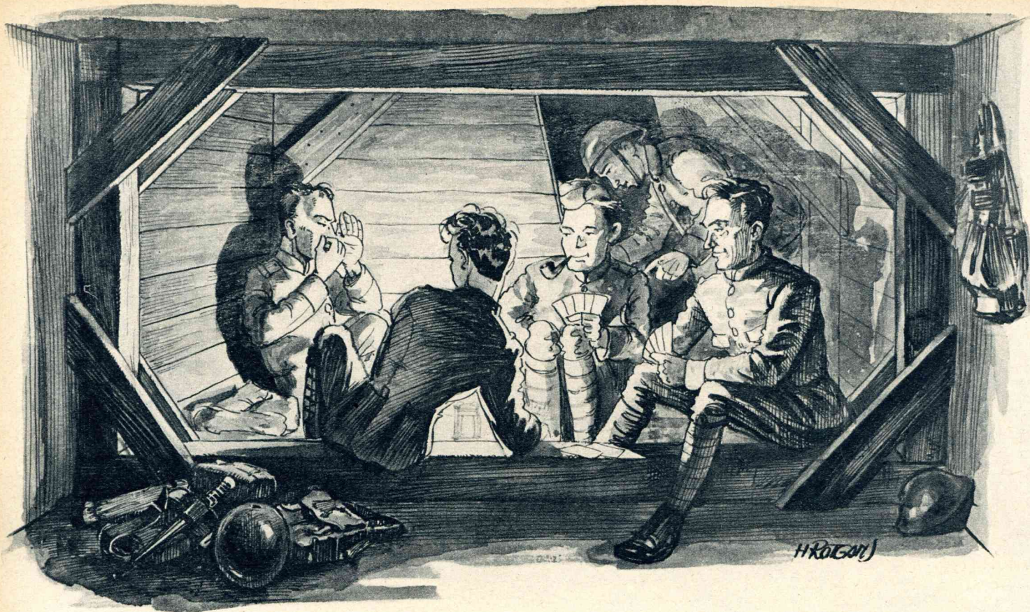
In de stelling. Beschut door zware grondmassa's doorwaken wij den nacht bij 't licht van een stormlantaarn.
