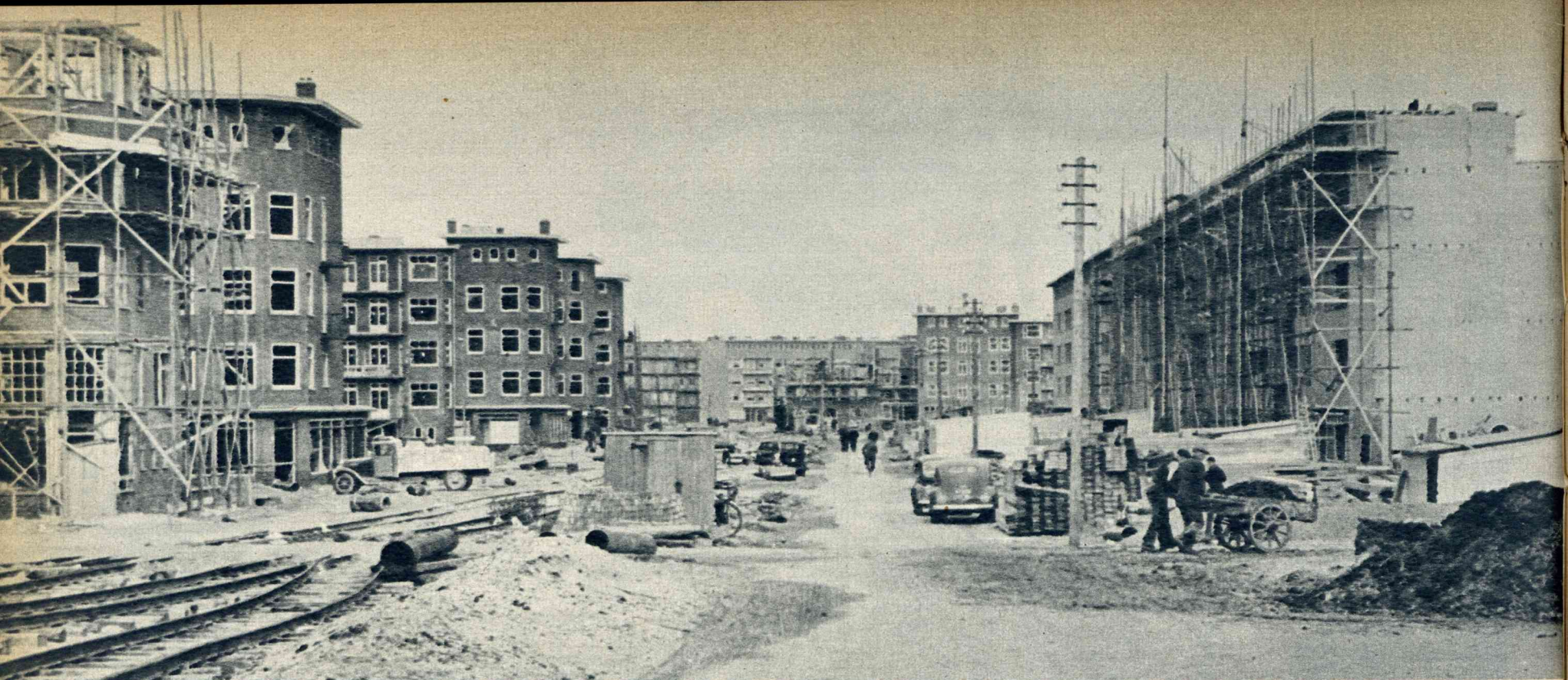
Een kijkje op de in aanbouw zijnde straat, welke de verbinding van den Adm. de Ruyterweg naar den Hoofdweg tot stand brengt.
