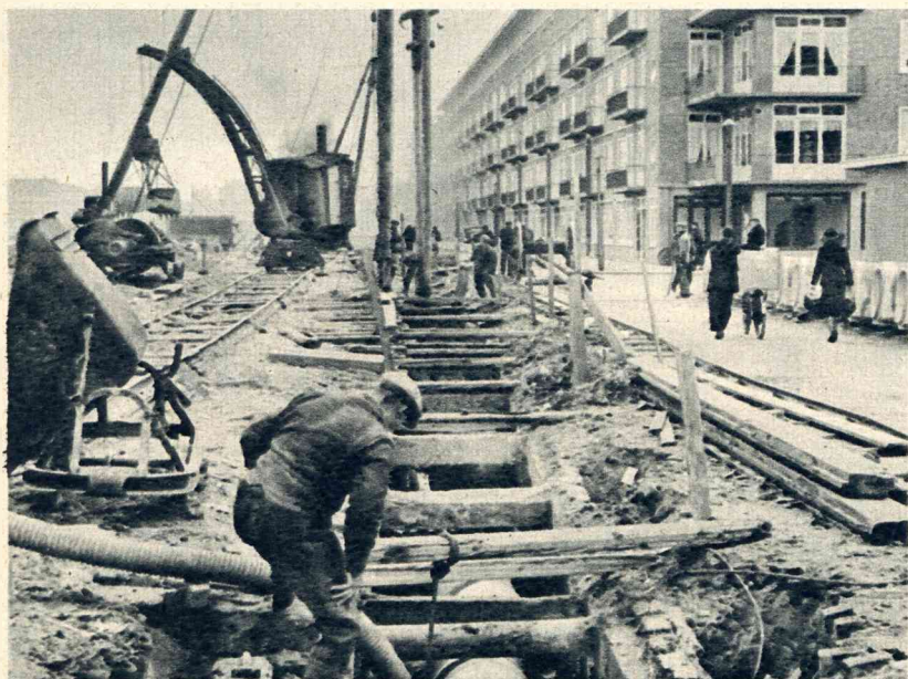
Terwijl de onlangs gereedgekomen huizen in de Egediusstraat reeds bewoond zijn, worden op het nog braak liggende terrein aan de overzijde der straat weer voorbereidingen getroffen om een nieuw huizencomplex te doen verrijzen.
