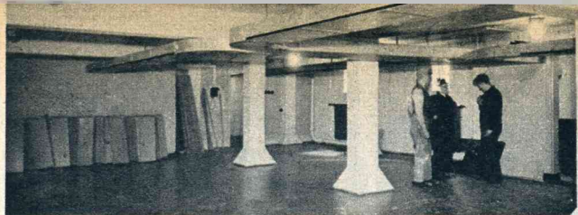
Een opname in een der schuilkelders, die tevens tot archief-ruimten zullen worden ingericht. Aan het plafond ziet men de kokers, waardoor bij een eventueelen gasaanval verse lucht wordt aangevoerd.
