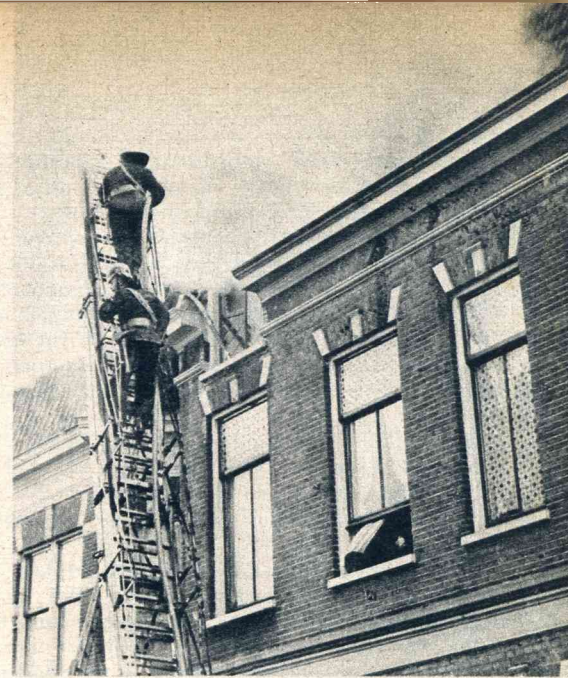
In een overbevolkt pension aan de Pieter Kiesstraat te Haarlem brak Zondagmorgen een felle brand uit, waarbij op zeer tragische wijze een der bewoners om het leven is gekomen. — Een opname tijdens het blussingswerk.
