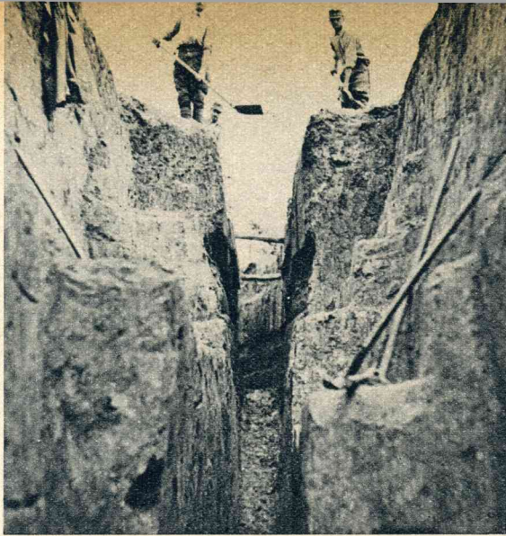
Soldaten graven de tankvallen uit en geven deze den voorgeschreven vorm.
