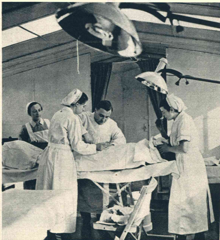
De operatiezaal van het rijdende ziekenhuis.
