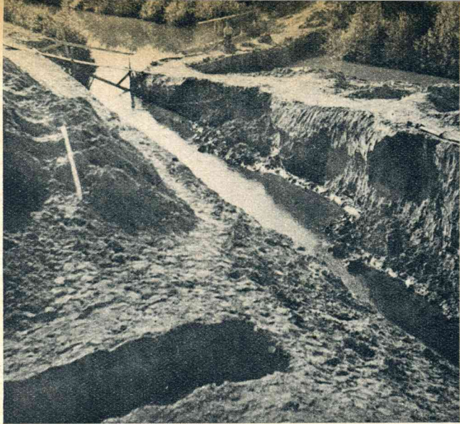
Met behulp van zware rupsbandploegen en baggermachines worden de kanalen gegraven.
