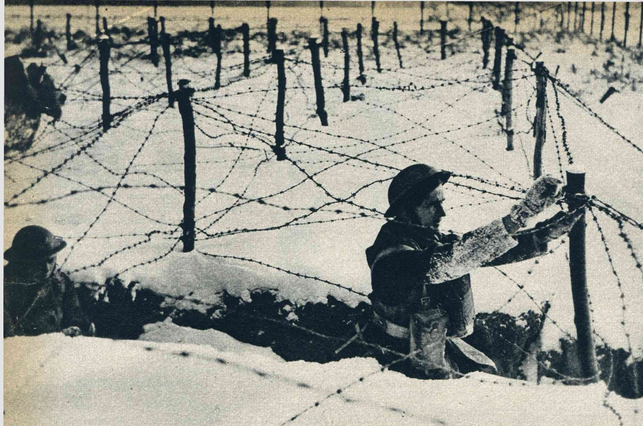
Het leggen van draadversperringen aan het westelijk front door Engelse soldaten.
