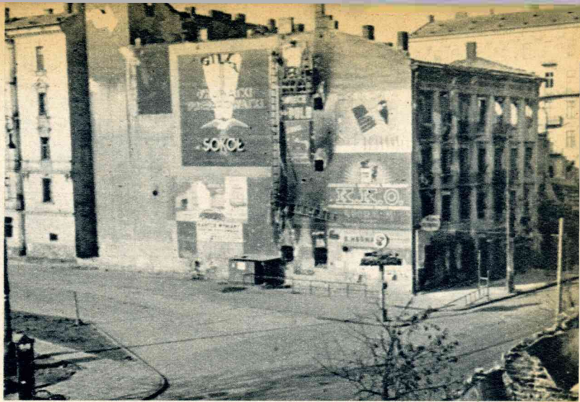
Vele gebouwen in Warschau zijn ten gevolge van het bombardement der stad zoo bouwvallig geworden, dat de Duitschers zich genoodzaakt zagen ze door middel van dynamiet op te ruimen. Bovenstaand huis vertoonde in den muur een diepe spleet en vormde dus een gevaar voor het verkeer.
