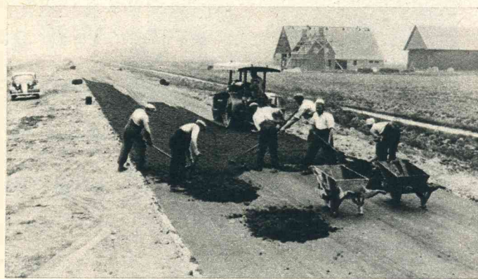
In den Wieringermeerpolder wordt wederom een 45-tal nieuwe boerderijen gebouwd, doch ook de hoofdweg Aardswoud-Wieringen, die dwars door de Wieringermeer loopt, wordt gedeeltelijk vernieuwd. Op den achtergrond een der in aanbouw zijnde boerderijen.
