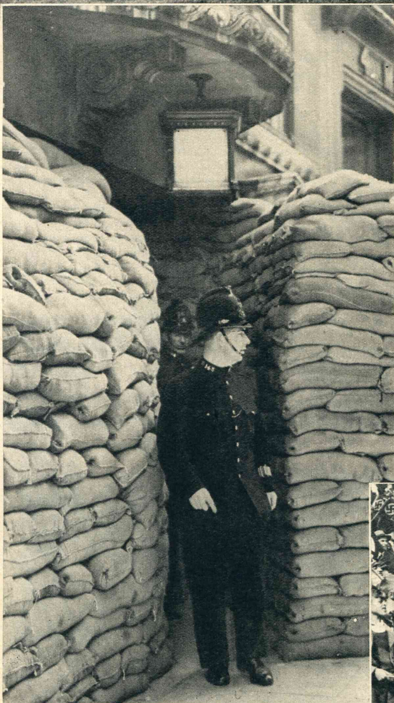
In Engeland werden verschillende gebouwen met zandzakken tegen luchtaanrallen beschut.
