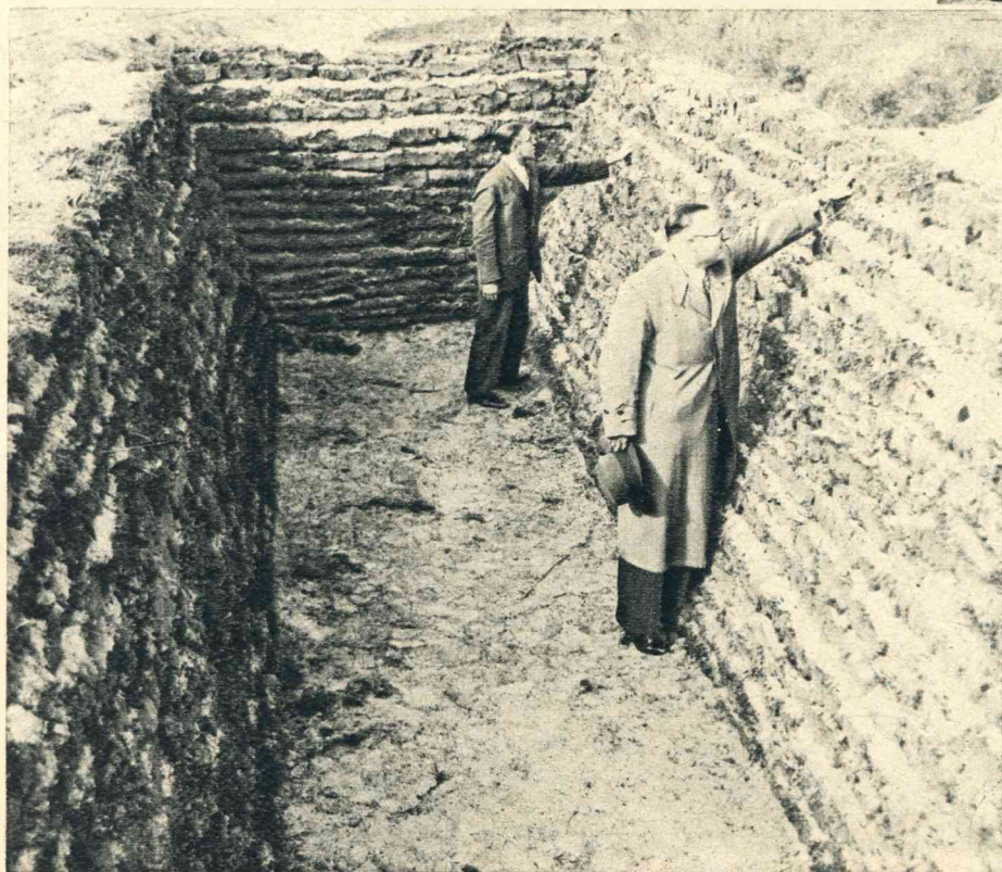
De gemeente 's-Gravenhage liet in verschillende deelen der stad schuilloopgraven aanleggen, waar in geval van nood 190.000 menschen beschutting konden vinden.
