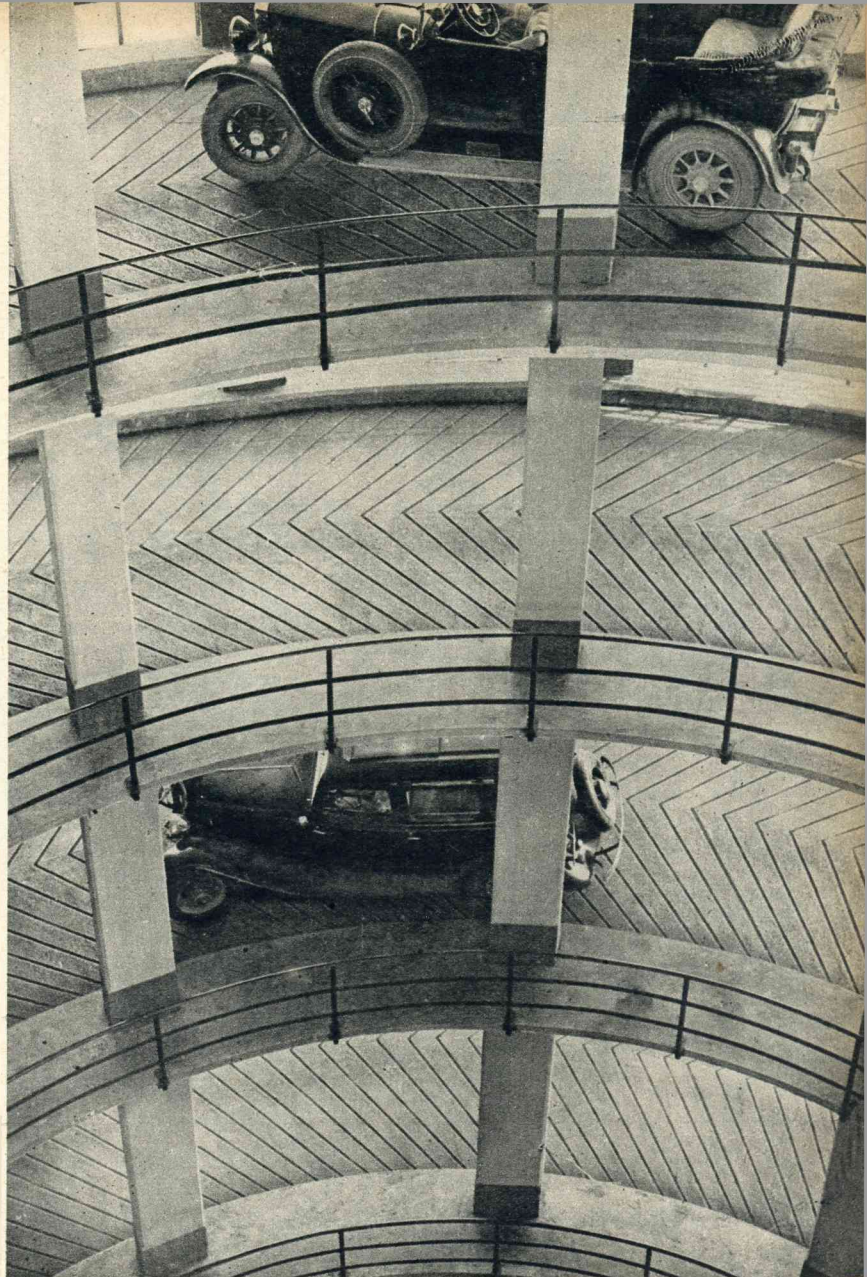
Nabij het station te Venetië is een enorme torengarage gebouwd, waarin honderden automobielen ondergebracht kunnen worden.
