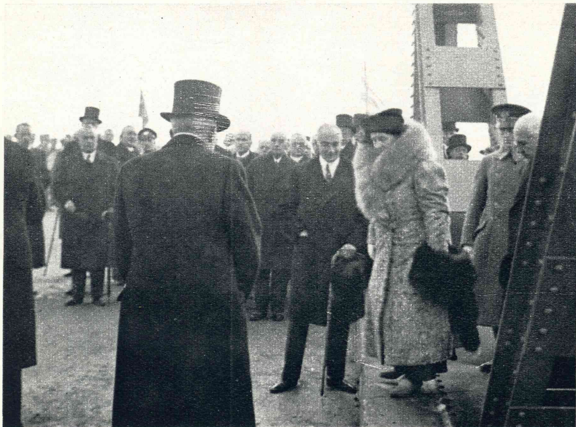
H. M. de Koningin betreedt den Brabantschen oever na te voet den kilometerlangen tocht over de nieuwe brug te hebben volbracht. De autoriteiten uit het Zuiden des lands wachten hier H.M. op.
