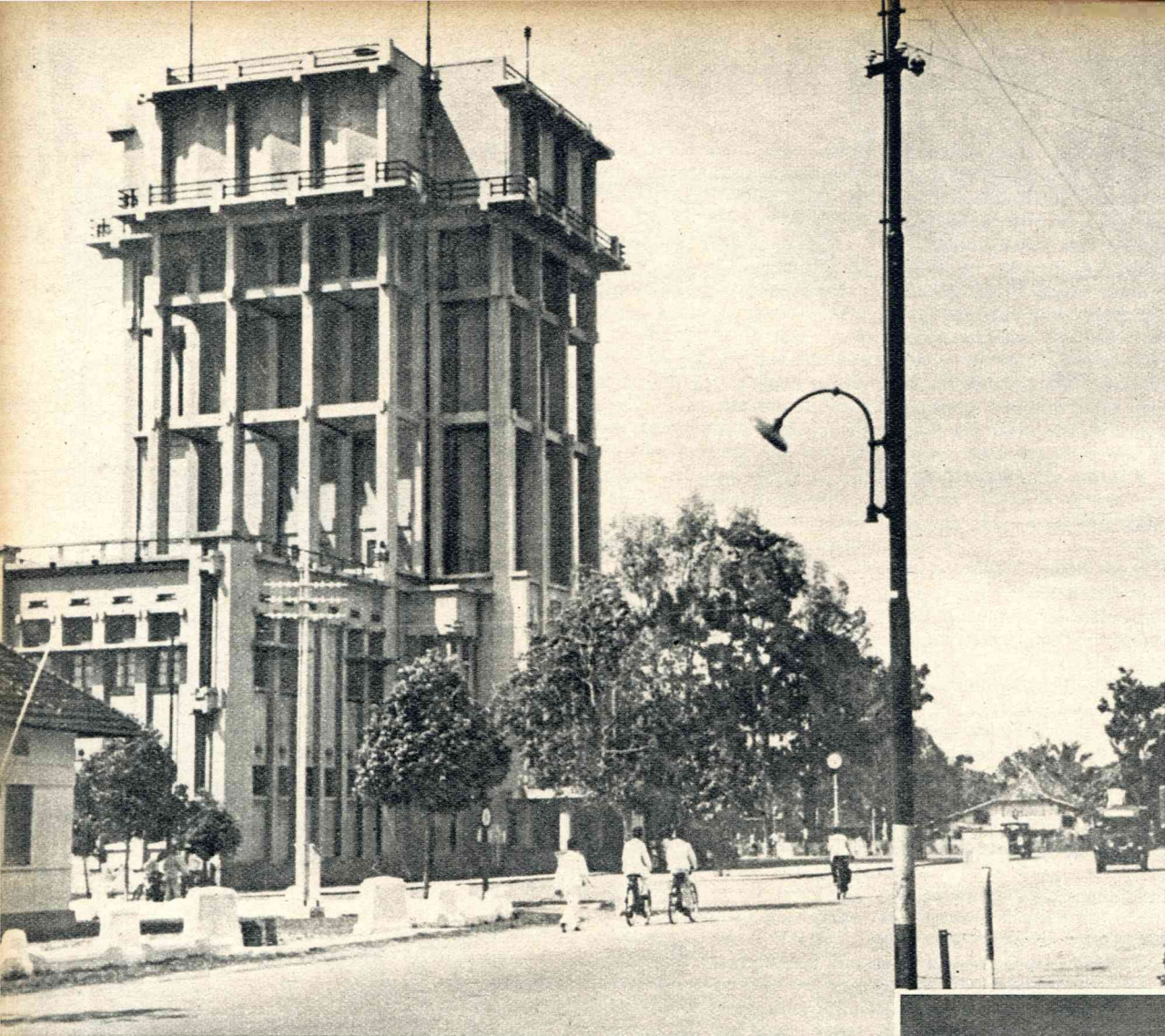
De gemeente Palembang (Ned.-Indië) heeft bij den aanleg van de rivierwaterleiding den watertoren, welke in het stadscentrum moest komen, gecombineerd met de eveneens noodige uitbreiding van het gemeentehuis. Op een belangrijk punt der stad is daardoor een merkwaardig doch karakteristiek bouwwerk ontstaan.
