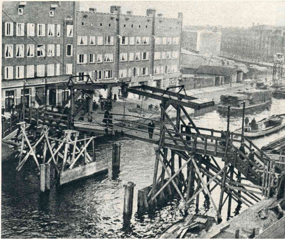
De hulpbrug over de Kostverlorenvaart bij de Borgerstraat kan het verkeer van en naar het Westen niet verwerken tijdens den bouw van de nieuwe brug tegenover de Kinkerstraat. Aan de andere zijde is nu een tweede noodverbinding gemaakt, speciaal voor voetgangers en fietsers.
