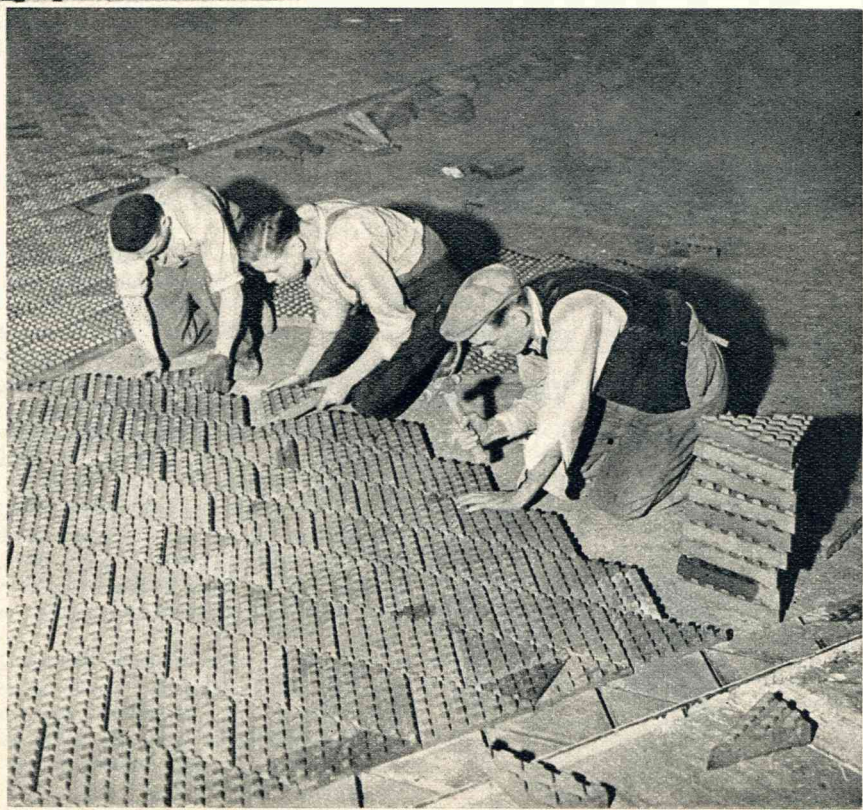
Voor de Agricultural Hall te Londen wordt over een afstand van eenige honderden meters een geheel metalen weg aangelegd. Arbeiders zijn bezig de metalen blokjes te plaatsen.
