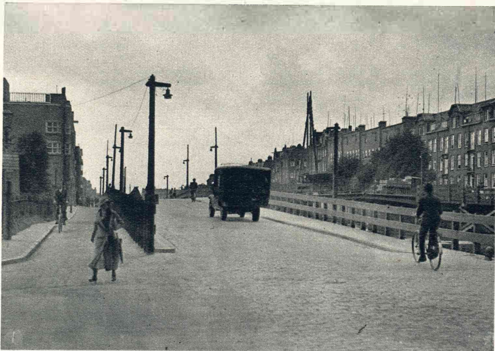
Op de Baarsjes zijn opritten gemaakt, daar de kade voor de hulpbrug te laag was.
