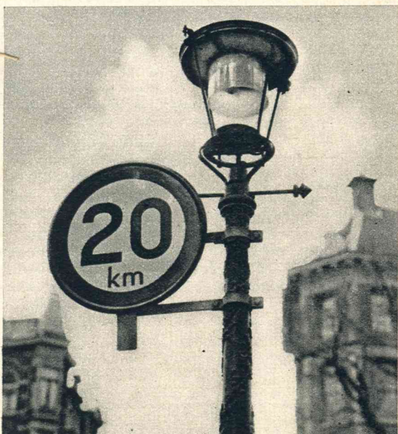
Op de Heerengracht bij de Spiegelstraat is een nieuwe proef voor straatverlichting genomen. De lamp is omgeven door een kraag van melkglas om een helder, niet verblindend licht te verkrijgen.
