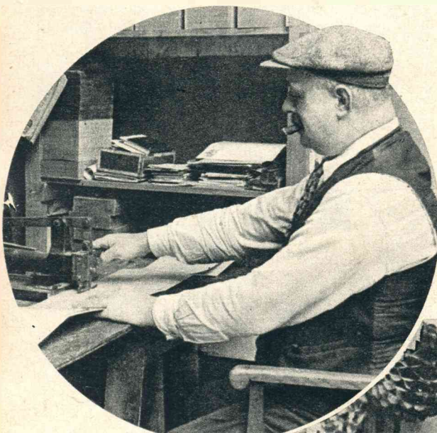
Met de muziek als model worden de gaatjes in het onderliggende karton geponst.
