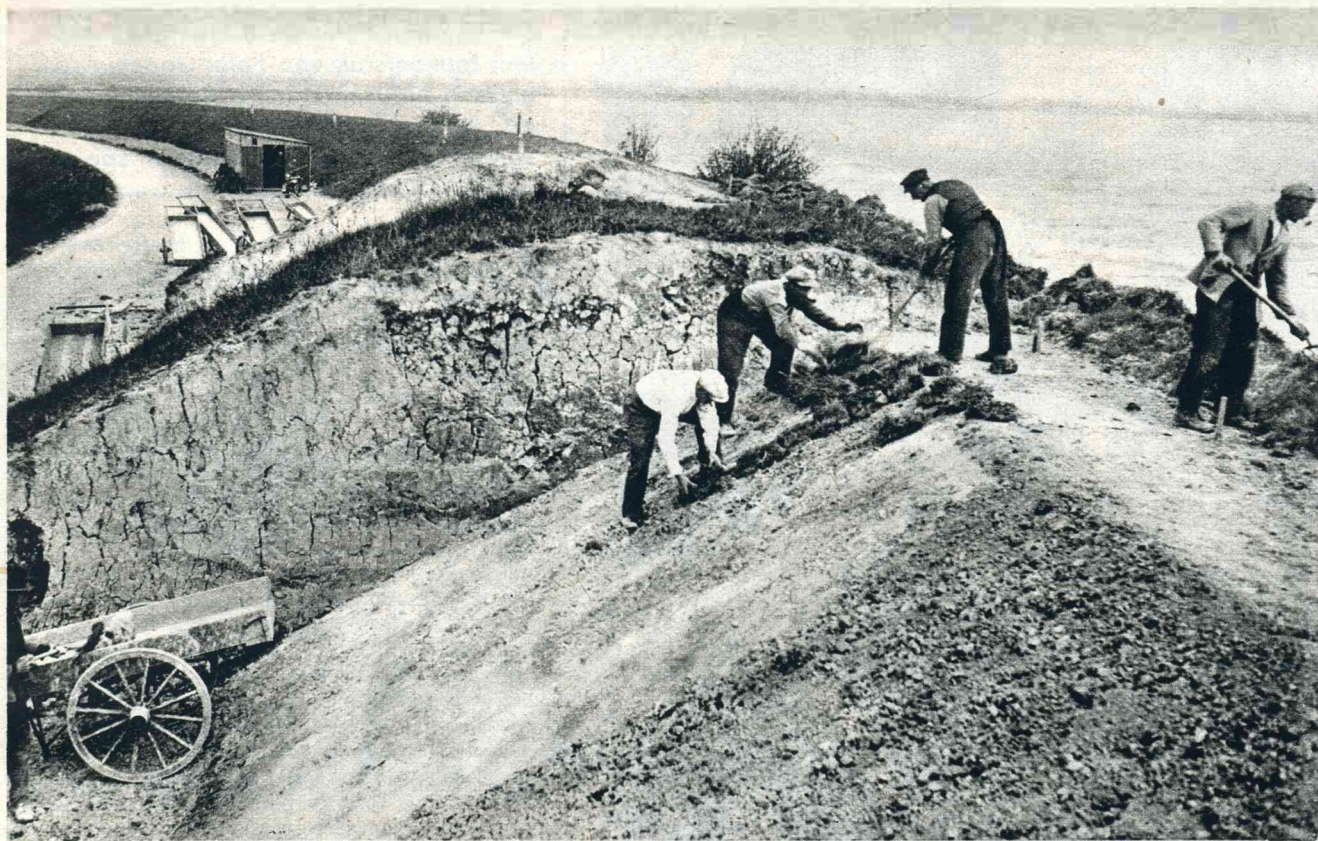
De dijk van het IJselmeer bij de Galgenbocht te Hoorn wordt, nu overstroming niet meer te vreezen is, verlaagd en smaller gemaakt, hetgeen ten goede komt aan den weg, die beneden langs den dijk loopt.
