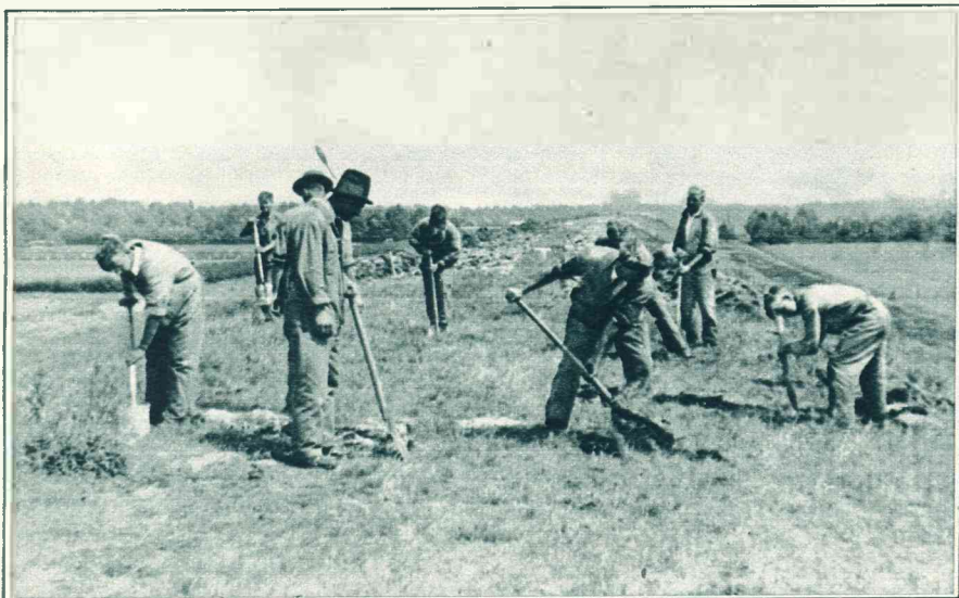
Op den Ringspoordijk wordt tusschen Amstel en Schinkel een fiets- en wandelpad aangelegd onder leiding van het Amsterdamsch Centraal Comité voor jongere werklozen. De jongens aan den arbeid.
