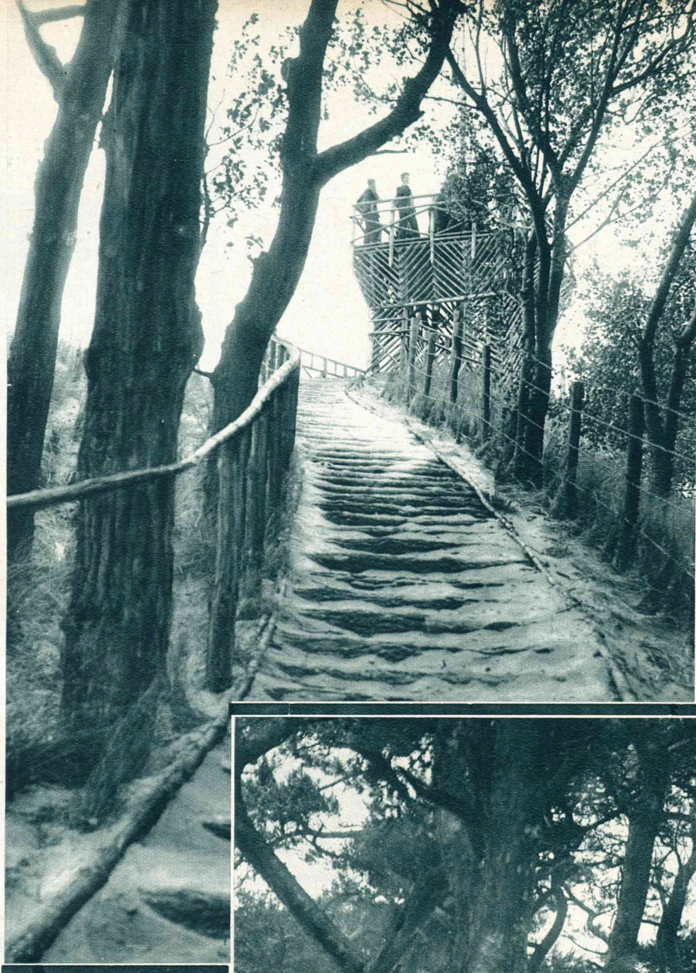
Uitzichttoren op den „Blinkerd”.
