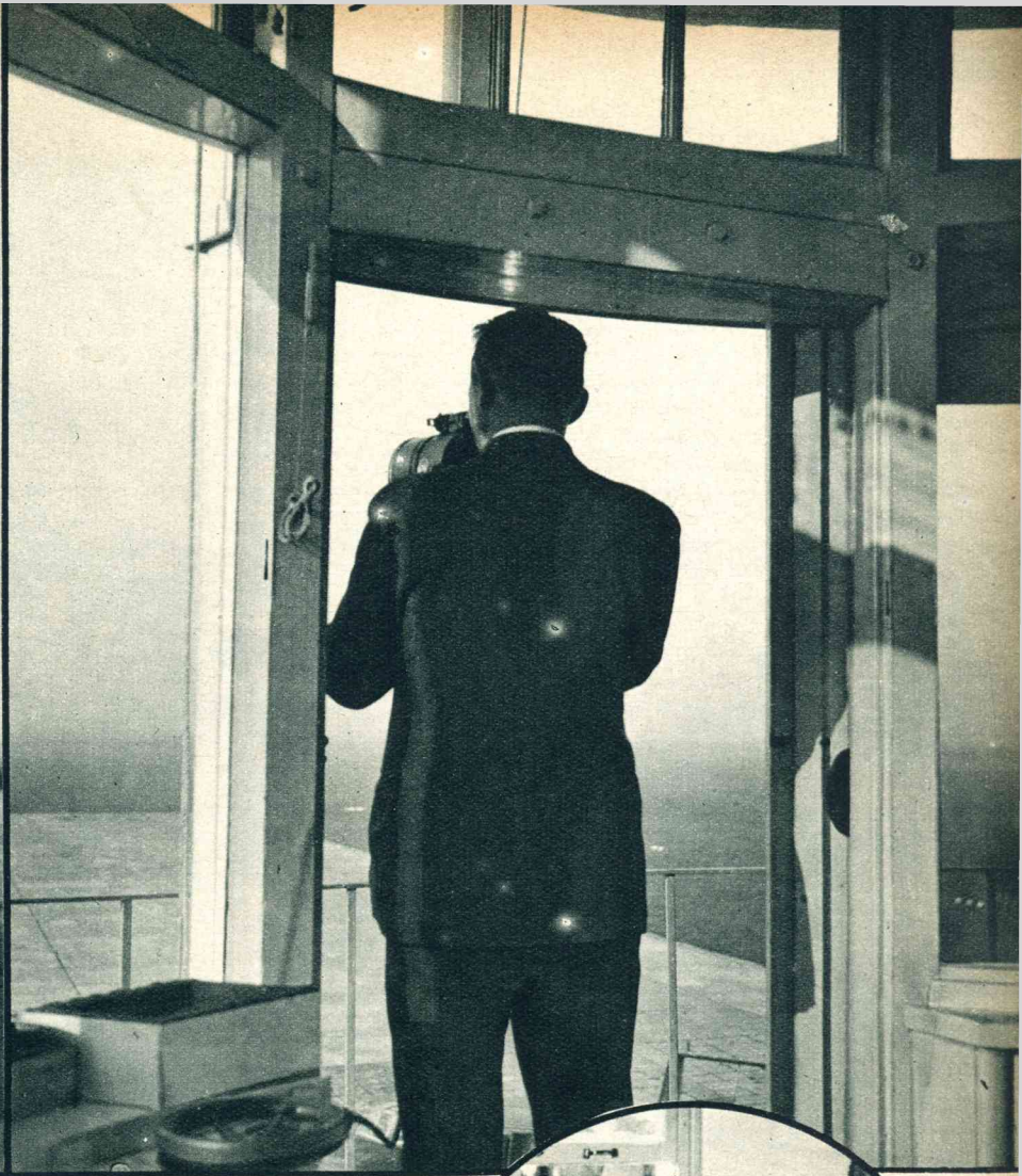
De chef van den Verkeersdienst geeft het vertreksein van uit den verkeersstoren. Hij doet dit door middel van een pistool waarin een lampje brandt, dat voor den piloot het sein is om te starten.
