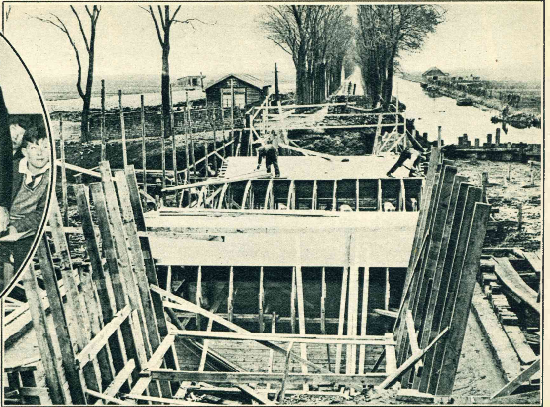
De werkzaamheden aan den nieuwen rijksweg Hoorn—Edam vorderen goed. De bouw van een nieuwe brug nabij Edam.
