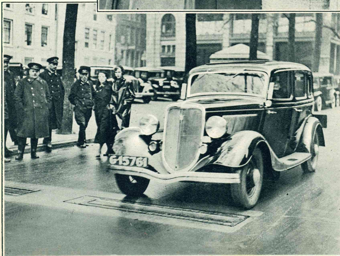
De verkeersdrempel op 't Spui, tegenover de Handboogstraat, welke een lichtsignaal-systeem in werking doet treden, is met succes in gebruik genomen. Een auto bij het rijden over den drempel.
