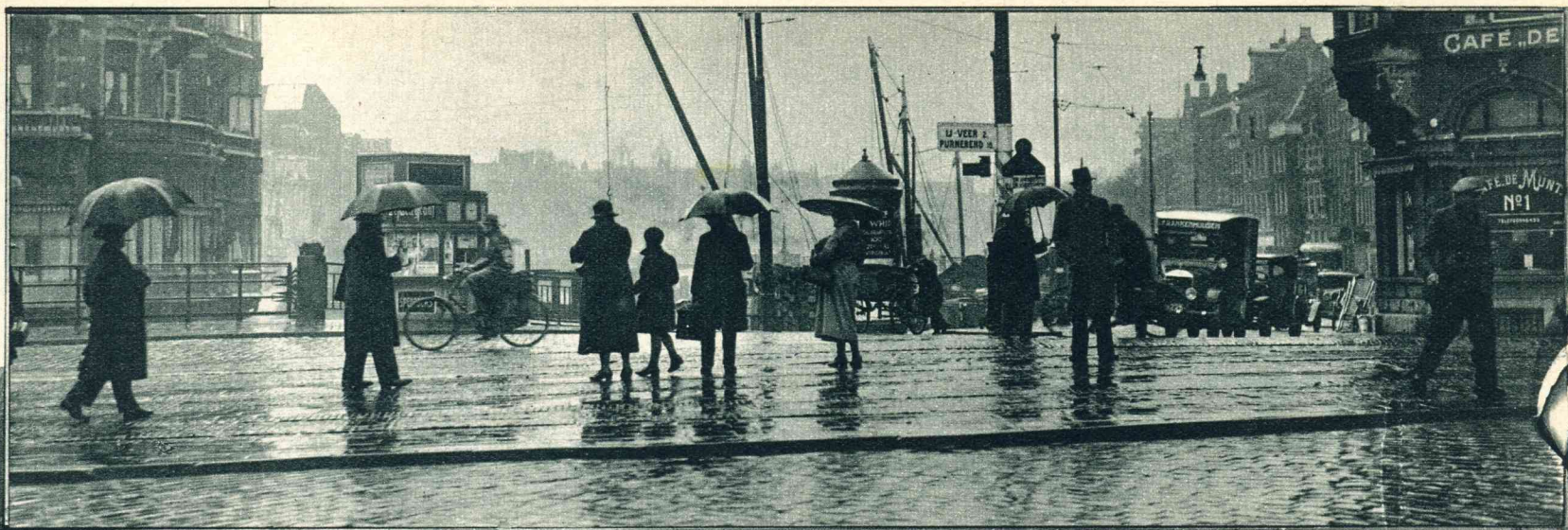
Regenstemming aan de tramhalte.
