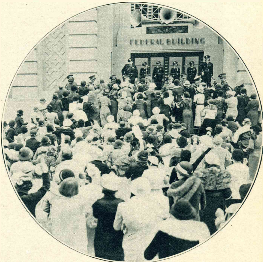
De bestorming van het regeeringsgebouw om een glimp van dat eigenaardige creatuur „man” op te vangen.
