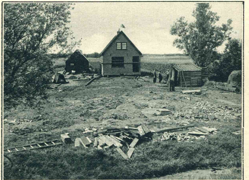
Het huis is goed overgebracht. Op den voorgrond de oude „standplaats”.
