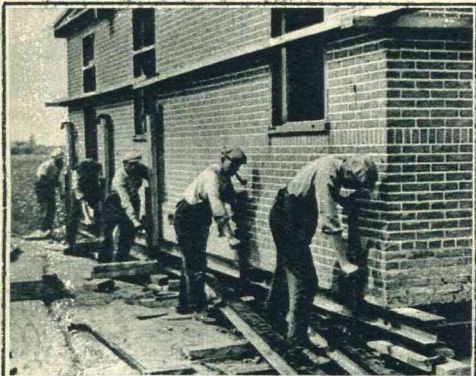
Te Heer Hugowaard was het, in verband met den aanleg van den nieuwen provincialen weg, noodig, dat een huis 40 Meter werd verrold. Na opgevoerd te zijn begon het transport van de woning, waarvan de muren maa. een halve steen dik zijn.
