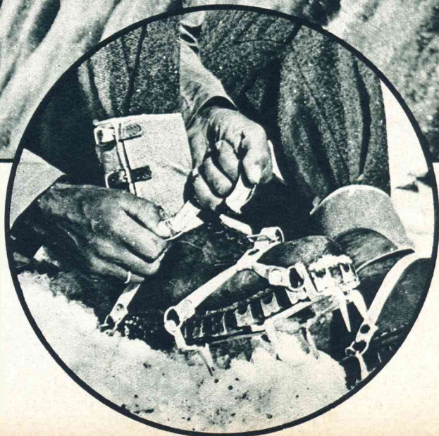
De klimijzers, van tien lange, spitse, stalen punten voorzien, worden aan de bergschoenen vastgesnoerd.
