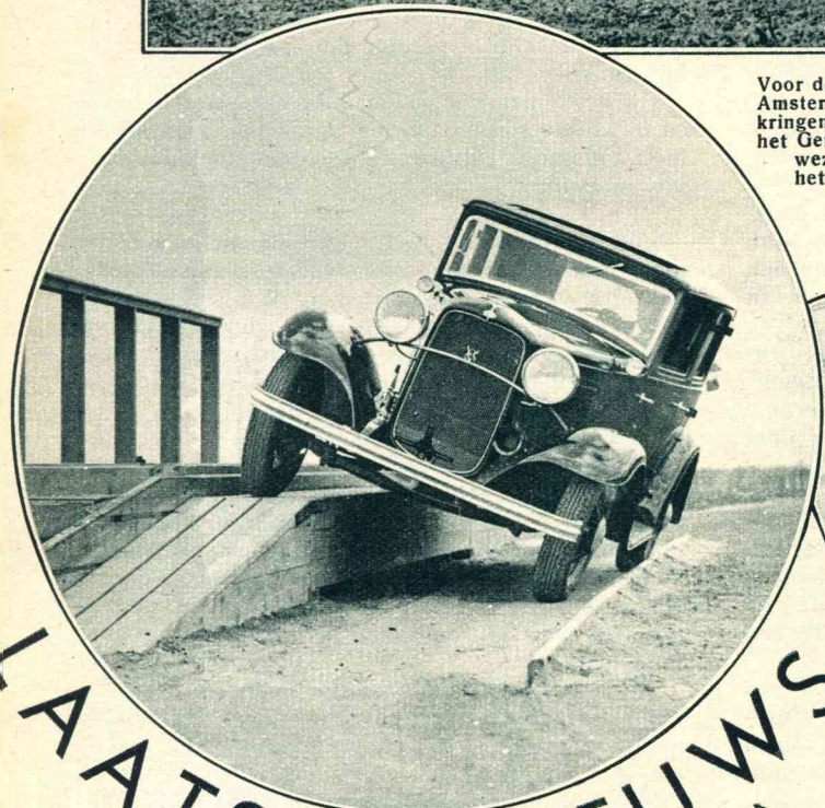
Voor de genoodigden werd het proefrijden van een wagen gedemonstreerd. De wagen moet met twee wielen over een helling van 20 graden rijden.
