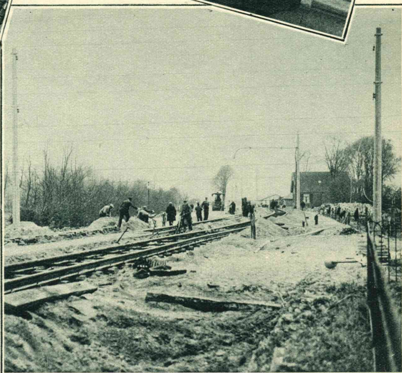
De electrificatie van de tramlijn Haarlem—Leiden vordert stadig. Een kiekje van de werkzaamheden nabij Hillegom.
