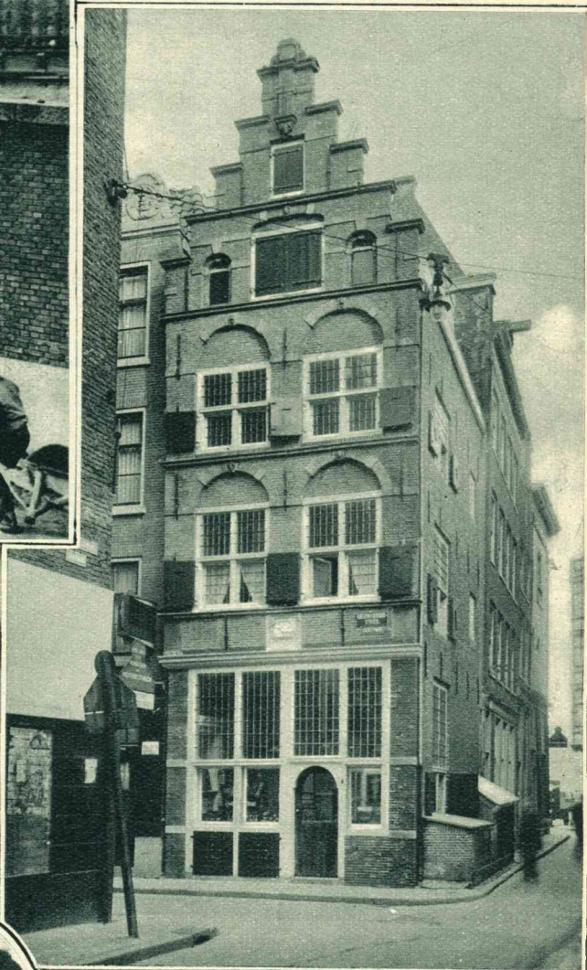
Het huis op de hoek van de Nieuwe Brugsteeg, dateerend uit 1619, is onder leiding van architect Jan de Meyer geres taureerd en door de Vereen. Hendrick de Keyser aangekocht
