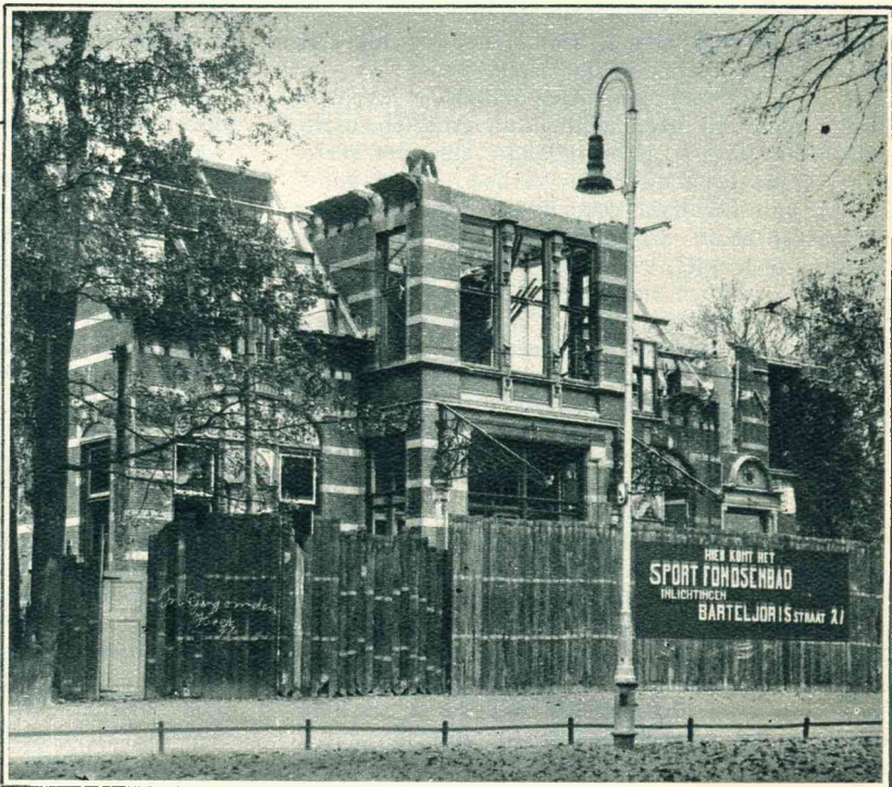
Te Haarlem wordt het bekende Brongebouw afgebroken. Ter plaats zal 't Sportfondsenbad verrijzen.
