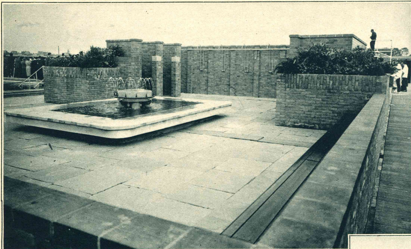
Het terras in de leeren-afdeling van de nieuwe zweminrichting.
