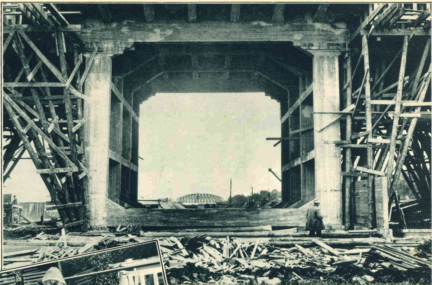
De bouw van de nieuwe verkeersbrug over het Merwede-kanaal aan den Muiderstraatweg vordert goed. Het eerste gedeelte is nu „houtvrij.” Op den achtergrond de spoorbrug bij Weesp.
