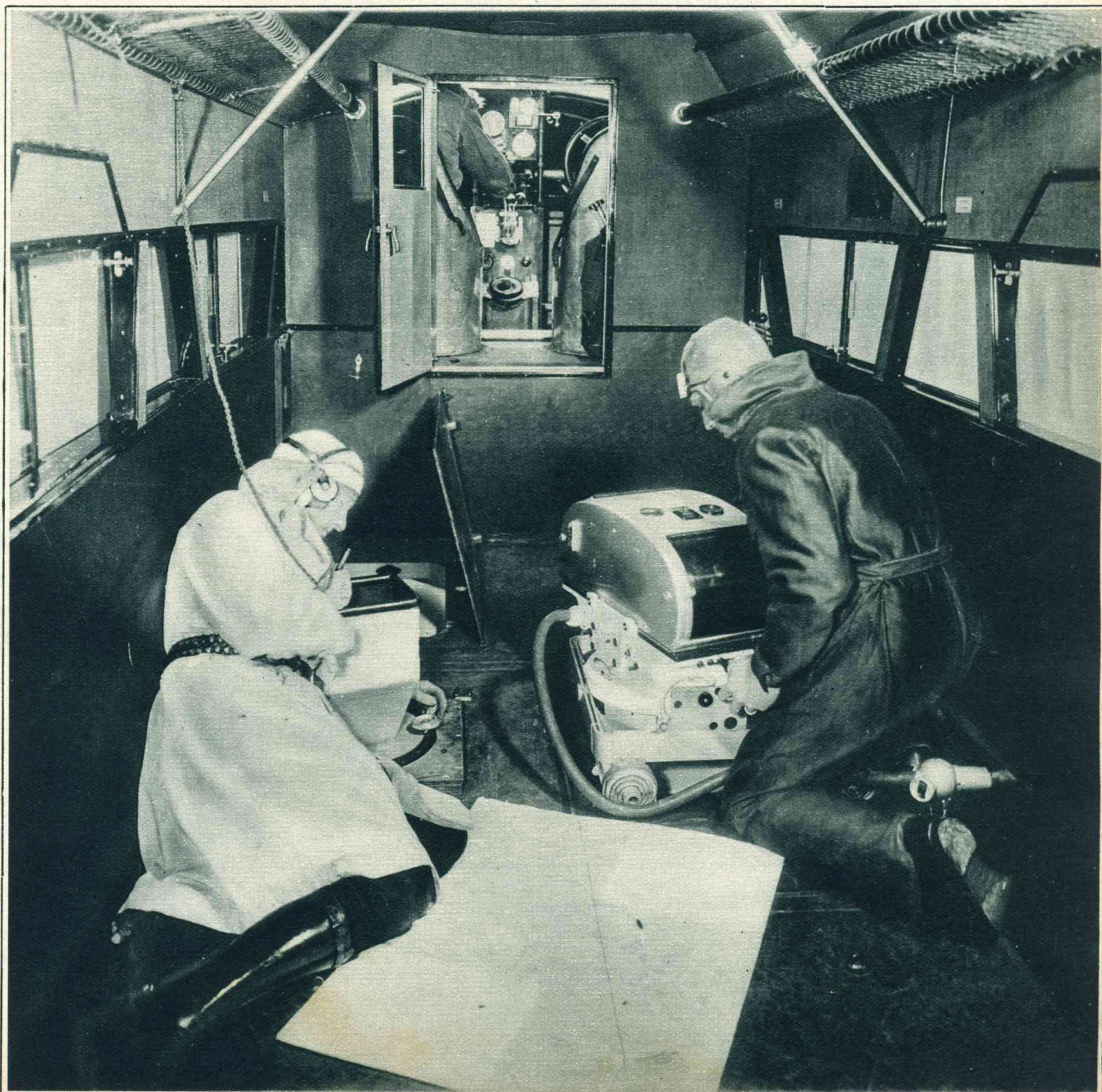
Landmeting door middel van luchtfotografie. In den bodem van dit speciale fotovliegtuig der K. L. M., de PH - OTO, bevinden zich verschillende openingen voor de camera's en navigatie-instrumenten, benodigd voor de luchtfotografie, cartografie en landmeting. Links de navigator, die telefonisch met den bestuurder verbonden is; rechts de fotograaf met zijn meetcamera. Achter in het vliegtuig bevindt zich een donkere kamer.
