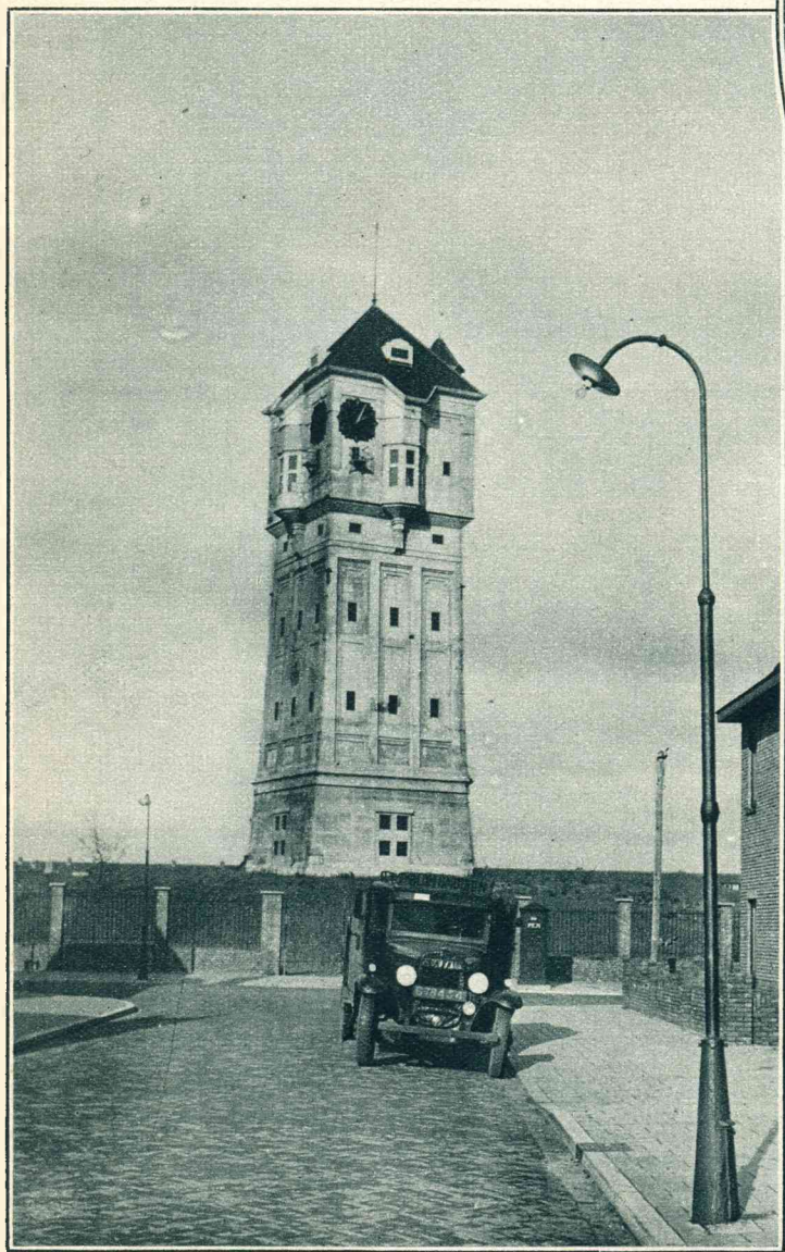
De watertoren te IJmuiden.
