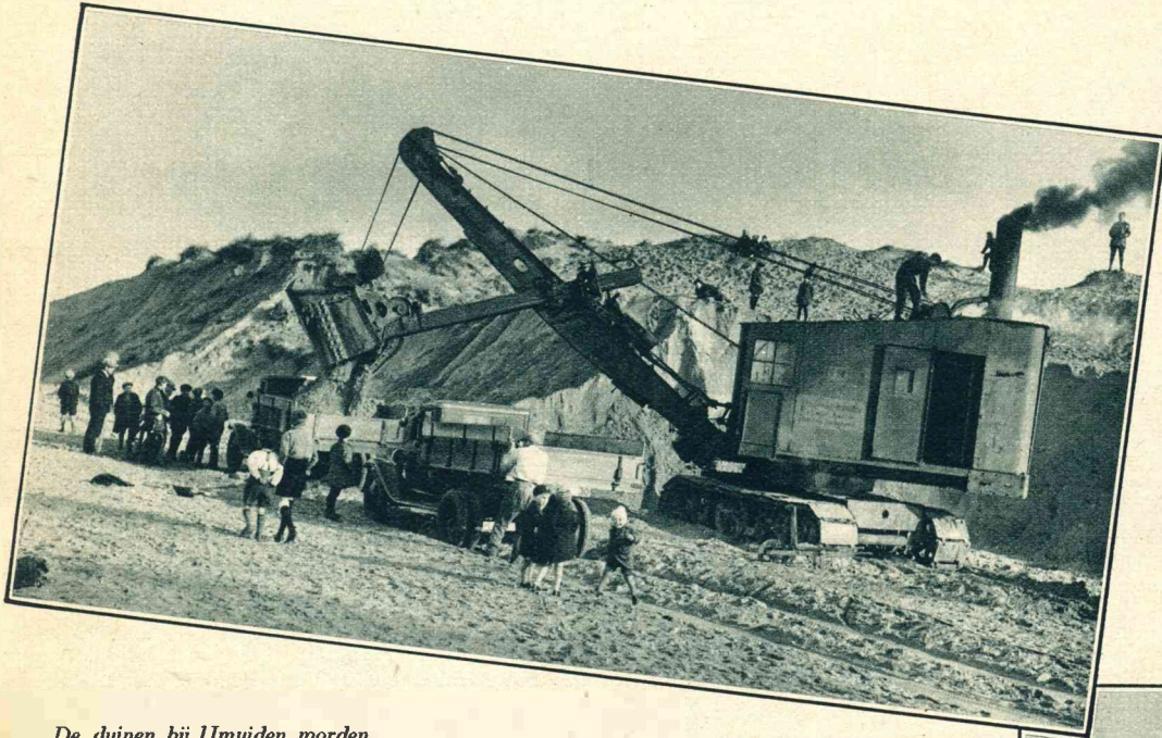
De duinen bij IJmuiden worden afgegraven, en hoe grondig, toont deze foto.
