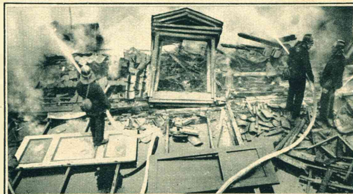
De smeulende achter- zijde van het dak.
